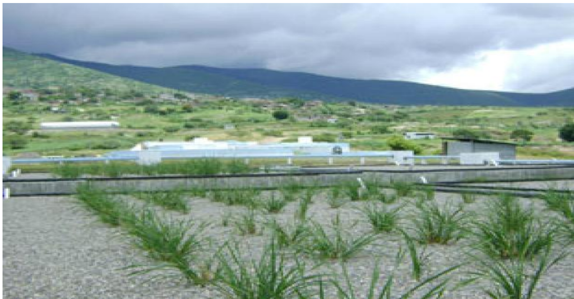
Figura 10. Humedal artificial para el tratamiento de aguas residuales domésticas. Tomado de Estadísticas del Agua en México, CONAGUA, 2010
