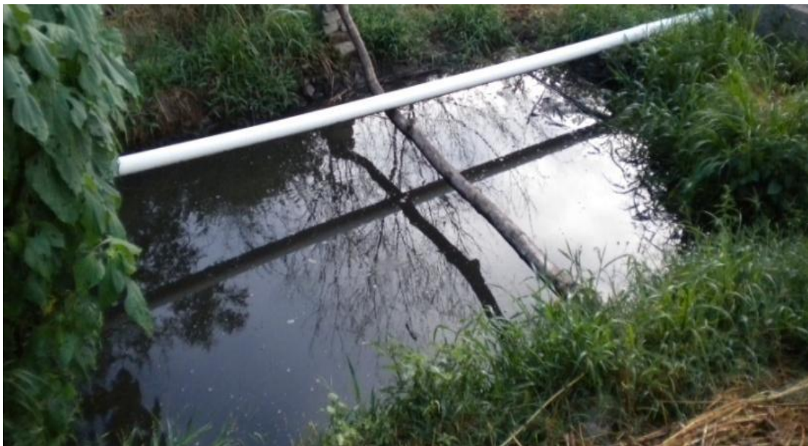
Figura 8. Laguna de estabilización rural de 5 m 3 . Apaxtla de Castrejón, Guerrero.
