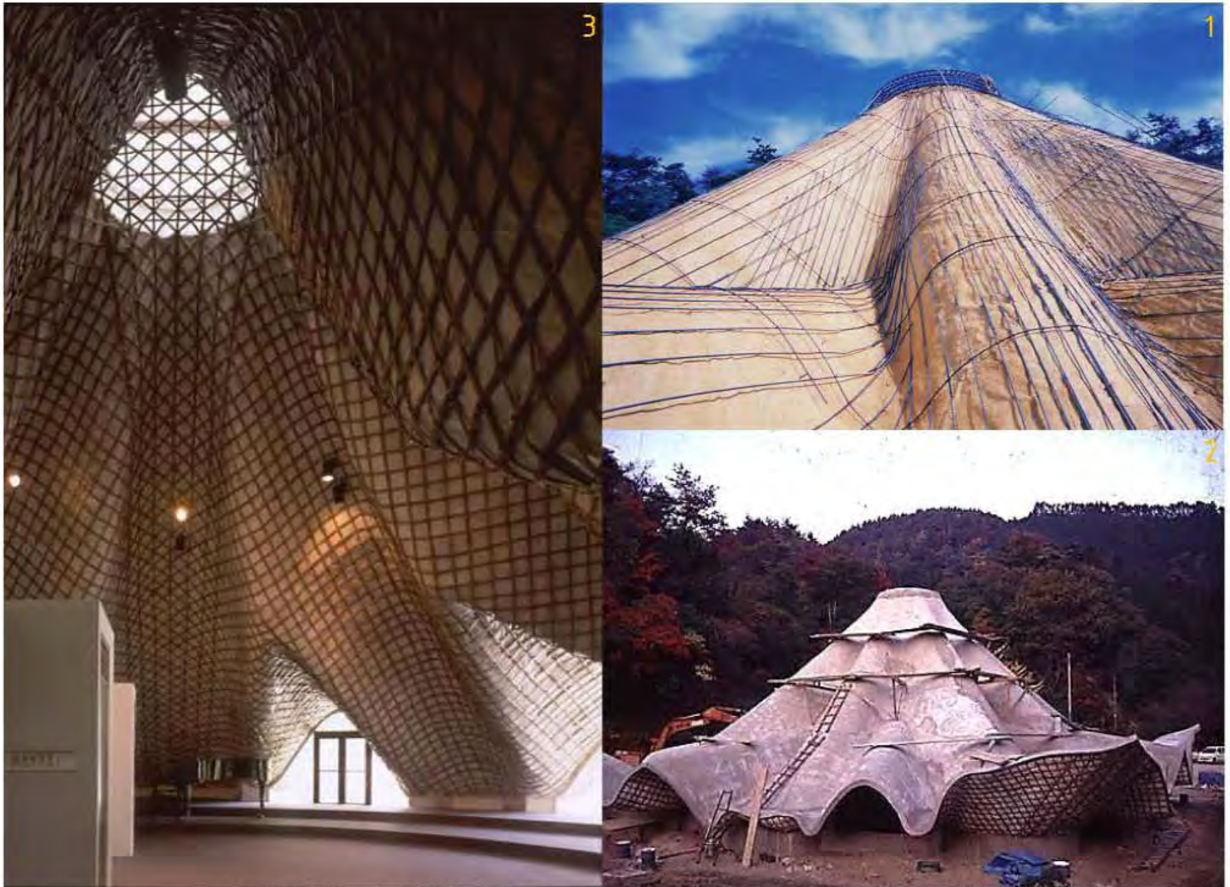
[1- Capa de poliuretano/ 2- Estructura con concreto concluido, lista para ponerle el manto impermeabilizante / 3-Vista interior concluida]
