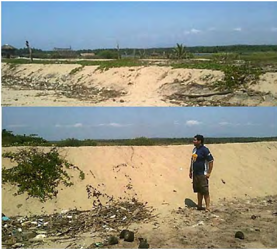
[v1] Vista del terreno / Taludes
