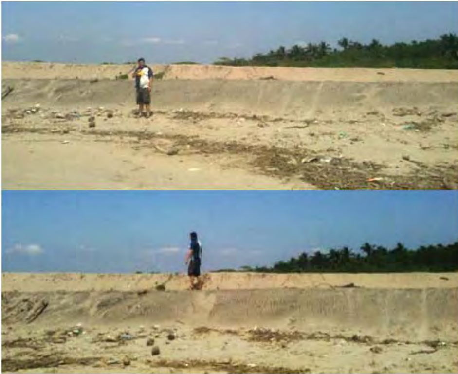
[v1] Vista del terreno / Taludes
