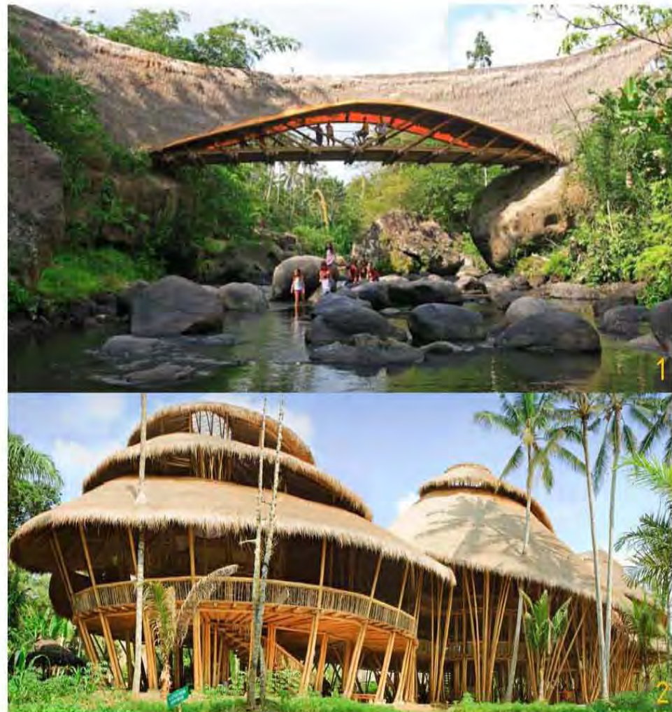
[1- Vista lateral de puente de acceso/ 2-Vista exterior –gimnasio, cocina, kindergarten y edificio principal]
