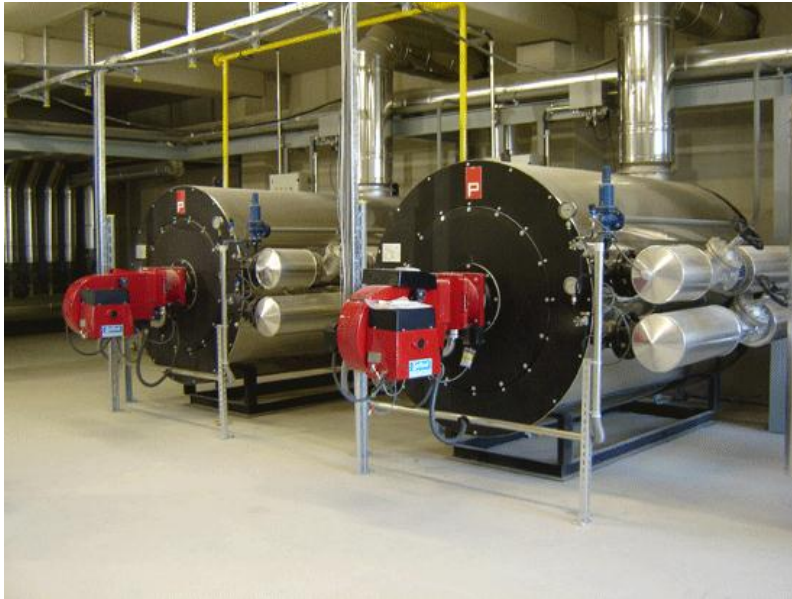
5 Fig. N° 1.4. Calderas de vapor a altas presiones fabricada con placas de acero inoxidable
