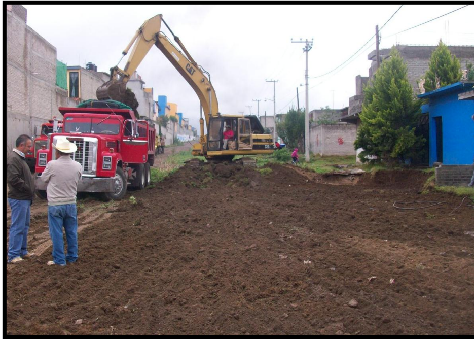
Aquí se observa la remoción del material vegetal
