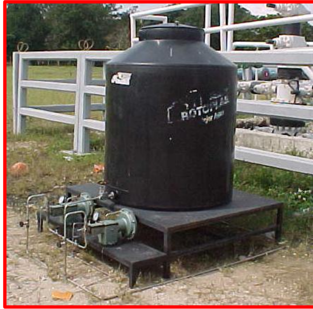
Fig. 2.6 Inyección inhibidores de corrosión. Fuente: ENX Compresores.
