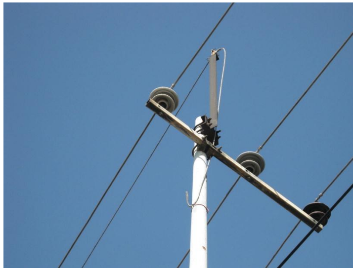
Figura AN.13.- Hilo de guarda sin aterrizar
