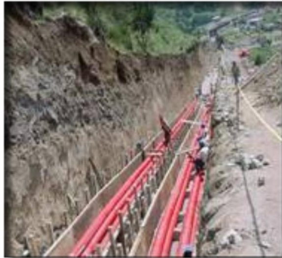
Figura 1.7.- Implementación de una red subterránea
