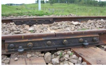
Figura 2.10. Junta de vía.
