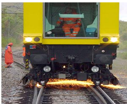
Figura 2.70. Vehículo adaptado para trabajos de mantenimiento de vía férrea.
