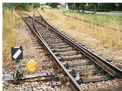
Figura 2.23. Palanca para cambios de vía de forma manual.
