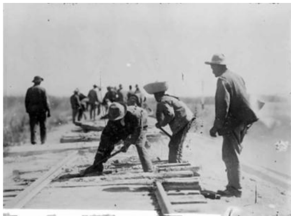
Figura 1.20. Fotografía de los hombres de Francisco Villa reparando las vías en las afueras de Torreón.
