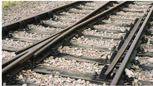
Figura 2.27. Agujas de ferrocarril.
