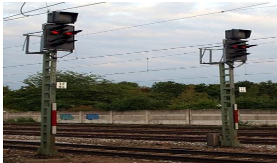
Figura 2.50. Señalizaciones de ferrocarril.
