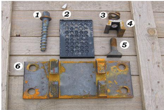
Figura 2.17. Principales elementos de fijación de una vía férrea.
