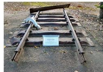
Durmiente metálico
