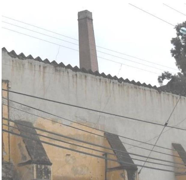
*Exterior de la fábrica de Miraflores actualmente en función y se observa el sistema constructivo original de ladrillo, tepetate y piedra volcánica en algunas de sus fachadas y contrafuertes; y el uso del ladrillo en su chimenea original. J. Arturo P. Escobar.*
