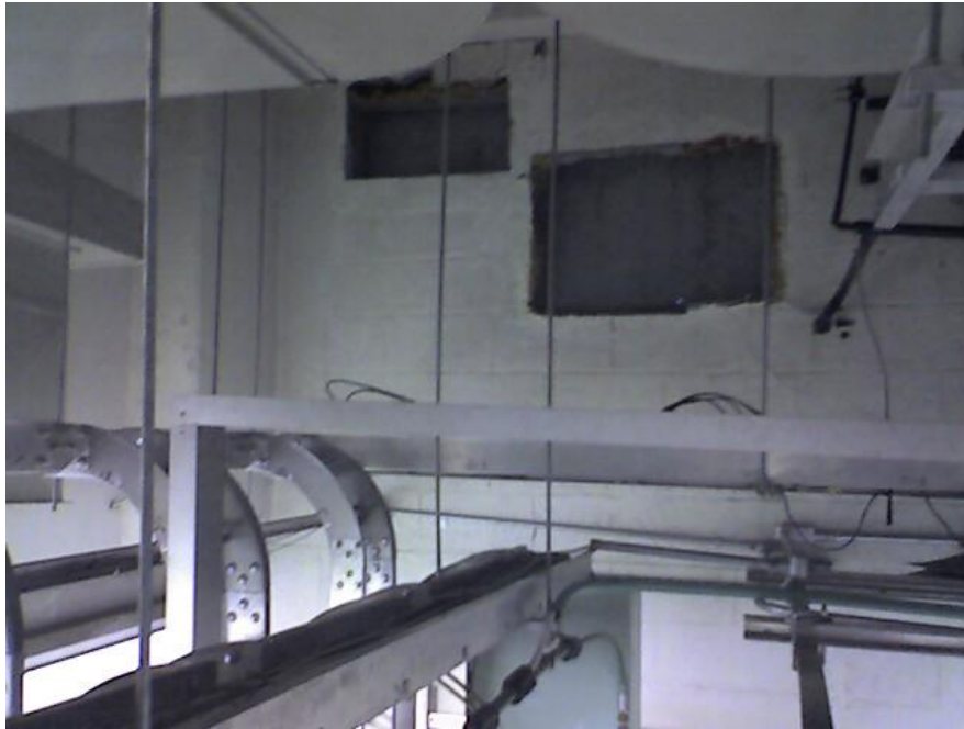
Imagen 7.4.6 Muro por donde entrará la ductería a la sala
