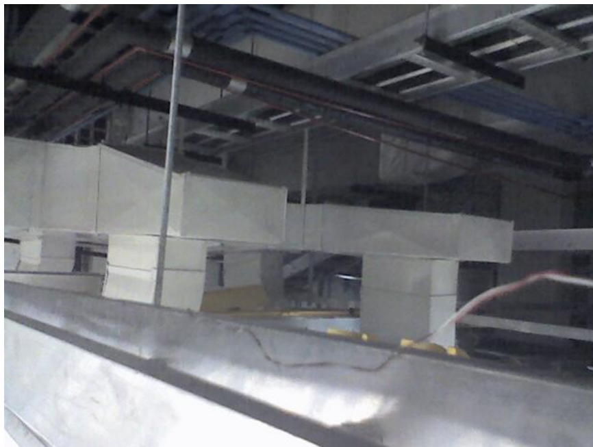
Imagen 7.4.8 ductería de sistema a desmontar al interior de la sala
