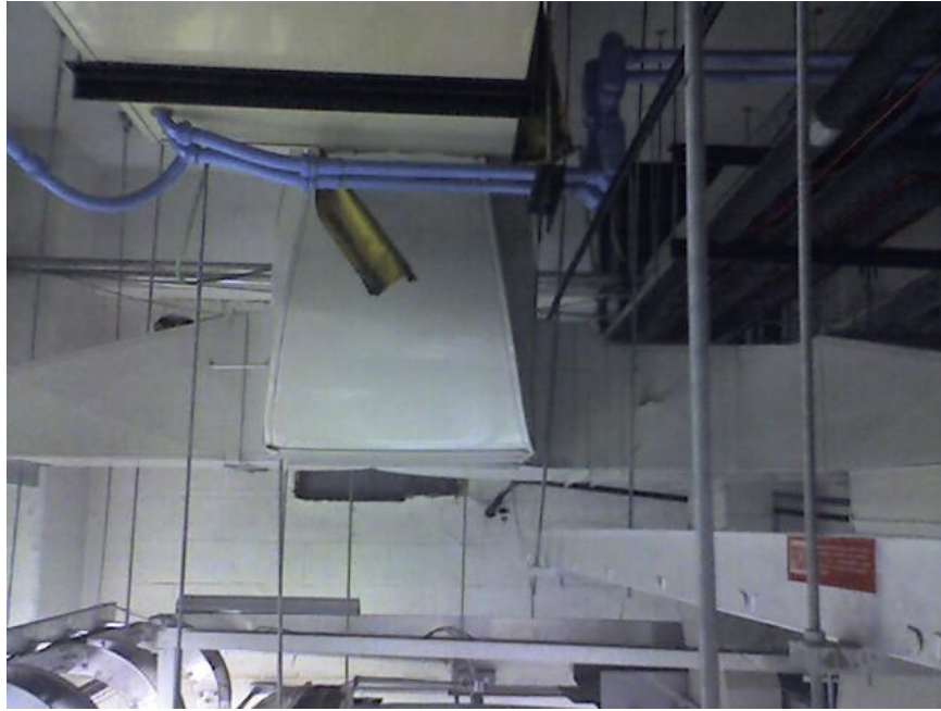
Imagen 7.4.7 Un sistema de cuatro a desmontar al interior de la sala
