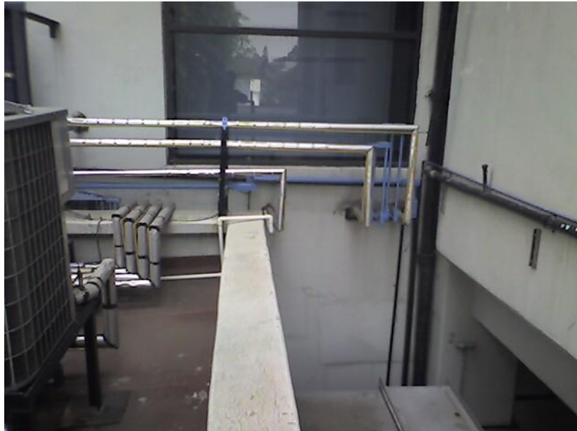
Imagen 7.4.4 Espacio por el que bajará la ductería
