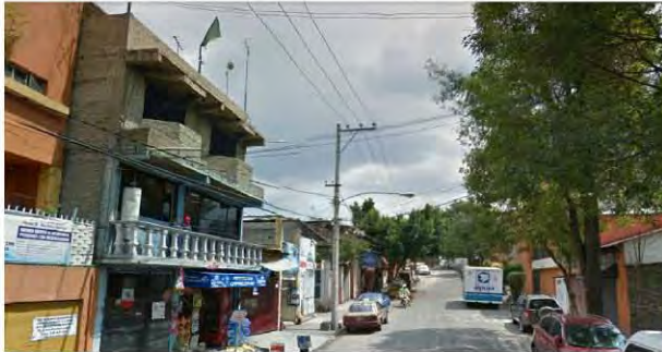
Algunas de las construcciones no tienen acabados o se encuentran incompletas.
