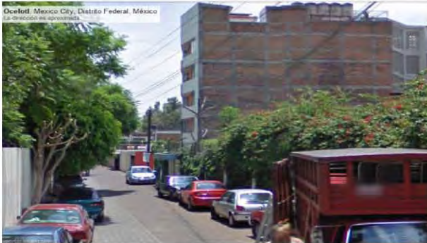
Existen edificaciones de hasta 5 niveles en esta vialidad.
