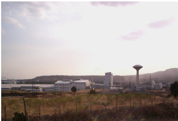
Fig. 4 Planta de la empresa Vetrotex que se abastece de agua de pozo y la almacena en un tanque elevado, Ciudad Industrial Xicoténcatl 1, Tlaxcala, México.
