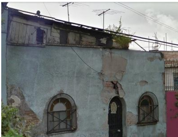
Fig. 60 Covacha sobre una azotea.
