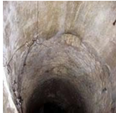
Fig. 19 Pozo de infiltración que conduce a la cisterna
