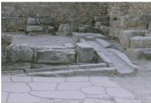
Fig. 11 y 12 Canales para conducir el agua pluvial en las ruinas de Cnosos.
