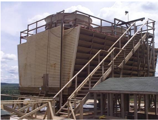
Fig. 5 En la industria el intercambio calorífico de muchos procesos se hace a través de torres de enfriamiento que usan el agua como vehículo para transportar el calor fuera de un proceso.
