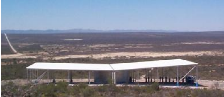
Fig. 30 Techo Cuenca diseñado para recolectar agua de lluvia para consumo humano, con tanque de 300 m 3 . Proyecto “Agua y Vida”, Mpo. Dr. Arroyo N.L.
