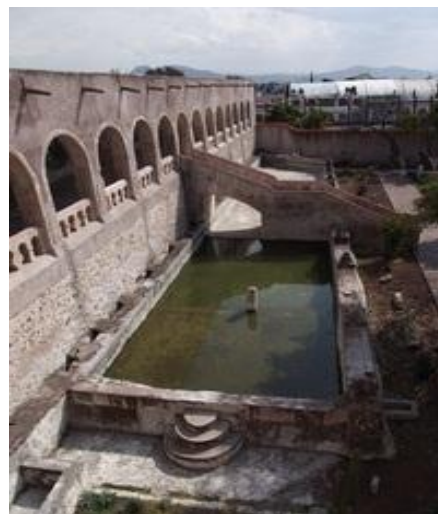
Fig. 26 Aljibe abierto del Convento de San Nicolás Tolentino en Actopan, Estado de Hidalgo, México.
