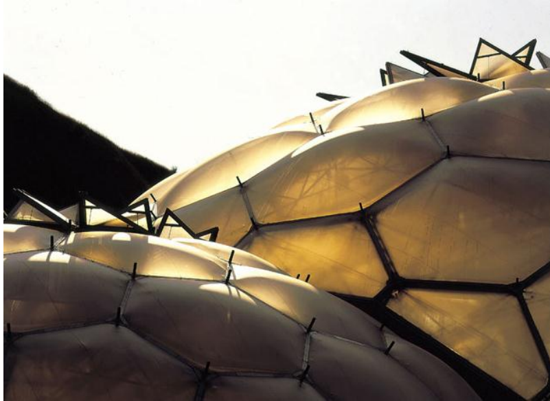
FIG. 115. ACERCAMIENTO A LA ESTRUCTURA DEL PROYECTO EDÉN.
