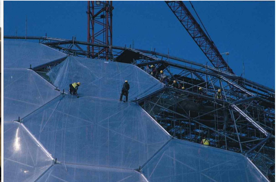
FIG. 116. PROCESO DE COLOCACIÓN DE LAS PIEZAS HEXAGONALES DE ETFE.
