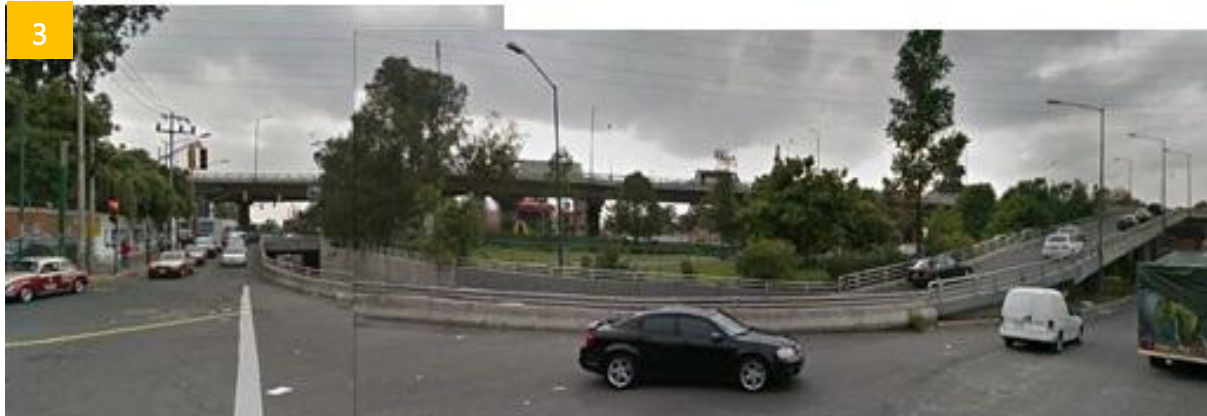
Fig.78. Se puede observar desde el terreno la intersección de las calles Nicolás Arvide y Minas, la salida del desnivel vehicular que entra por Prolongación San Antonio, así como el puente que se eleva sobre Av. Alta Tensión.
