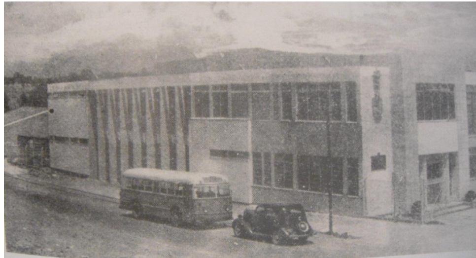
FIG. 20. FACHADA PRINCIPAL DE LOS LABORATORIOS DE INGENIERÍA EXPERIMENTAL DE LA SECRETARÍA DE RECURSOS HIDRÁULICOS, EN TECAMACHALCO, DISTRITO FEDERAL, 1947.
