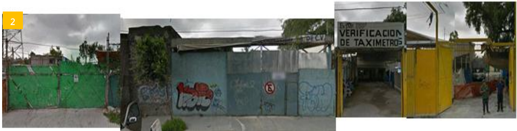
Fig. 77. Al sur, sobre la calle Nicolás Arvide, se ubican esta serie de bodegas y estacionamientos. La contaminación visual y auditiva por el tráfico que se genera en este punto, hacen que el sur sea la peor vista, conviniendo que el proyecto de edificio se cierre a esta zona.
