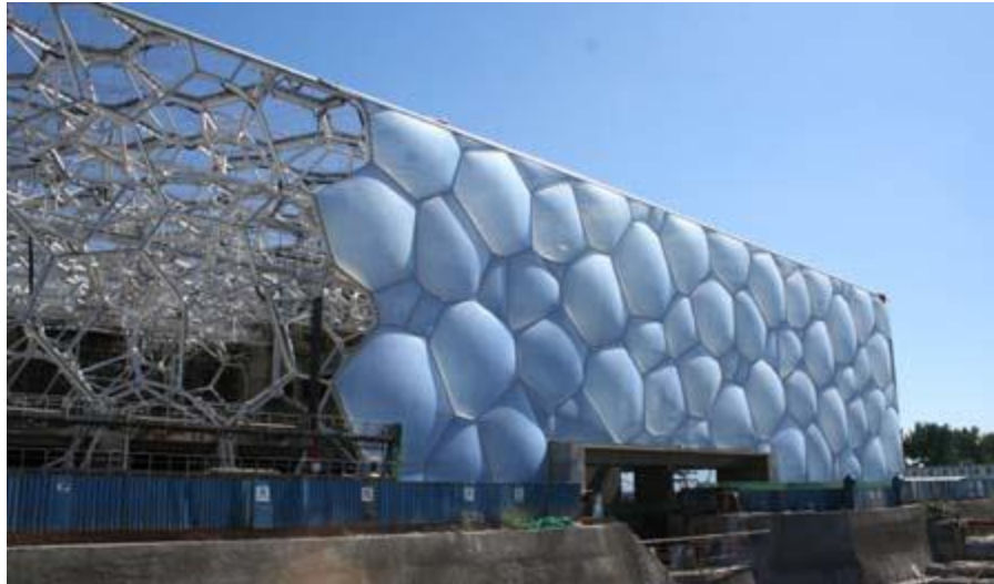
FIG. 120. IMAGEN DEL CUBO DE AGUA EN PROCESO DE CONSTRUCCIÓN.
