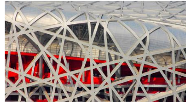
FIG. 118. EN LA IMAGEN SE PUEDE APRECIAR LA UNIÓN DEL MATERIAL POLÍMERO CON LA ESTRUCTURA DE ACERO.
