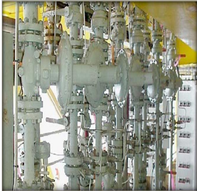
Figura 3.6 – Cabezales de bombeo neumático con válvulas de control, TMV y medidores de orificio tipo brida 1 .
