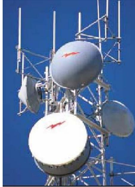
**Fig. 2.4 Sistemas de radio donde la unidad de antena RF es montada al aire libre.**
