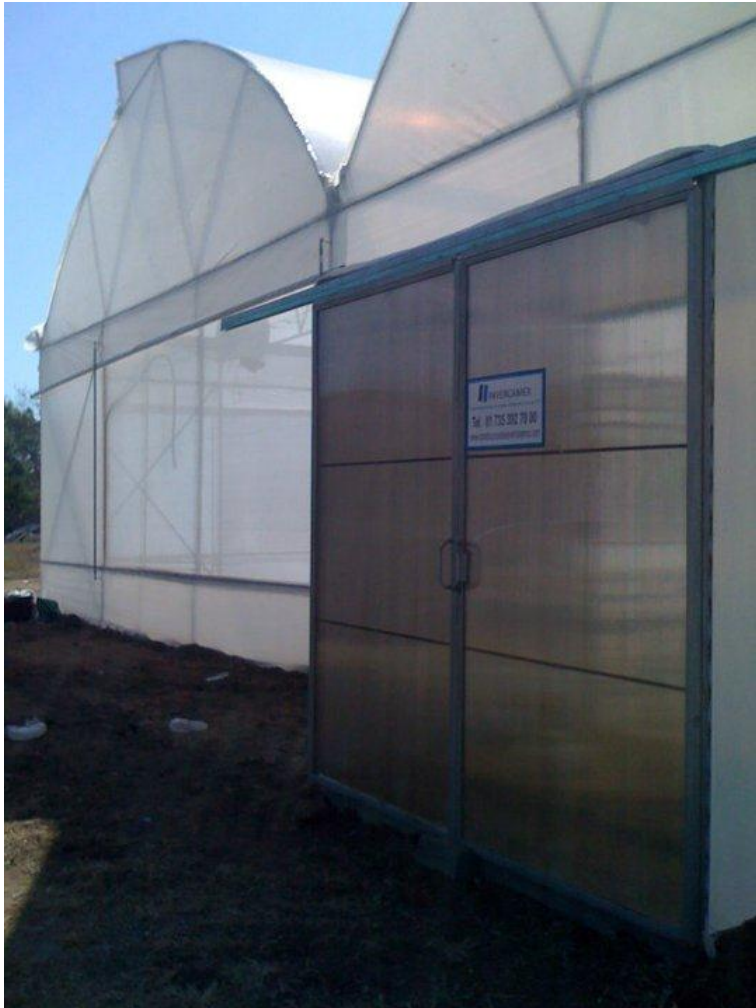
Imagen. 33 Puerta fitosanitaria frontal del invernadero
