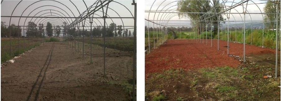
Imagen. 29 Comparativa del antes y después de la colocación del tezontle dentro del invernadero
