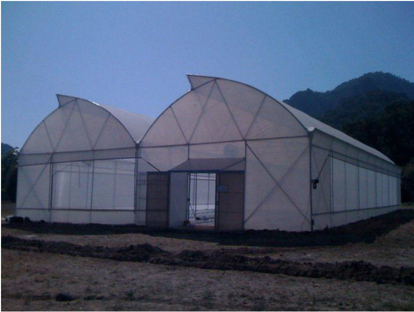
Imagen. 40 Invernadero bitunel de 600 m 2 construido en el Ejido de Tláhuac.
