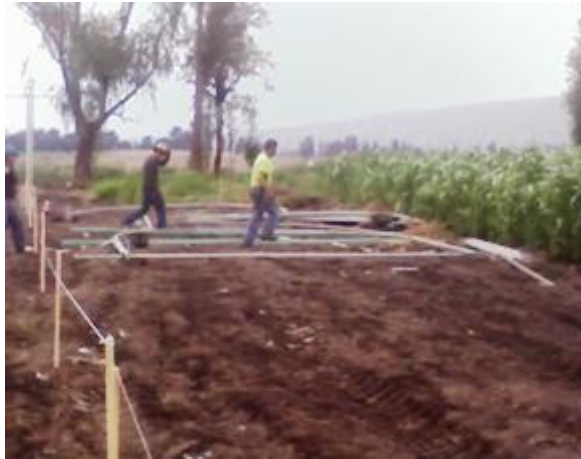
Imagen. 20 Colocación de estacas para el trazo.
