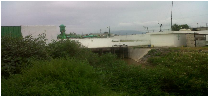
Imagen 11. Cárcamo de Bombeo del Canal General
