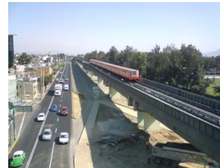
Sistema de Transporte Metro
