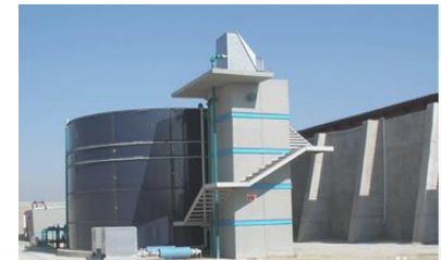
Foto 29 a) plaza y andadores b) villa atlética c) planta tratamiento del CAR Tijuana, Baja California
