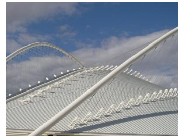
Tensores Cubierta Foto 49
