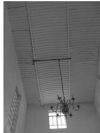
[24. Fotografía del entrepiso bóveda de lámina de zinc, edificio Gregoire de Wollant]
