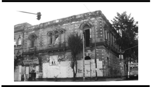
[6. Edificio Gregoire de Wollant, 2012]
