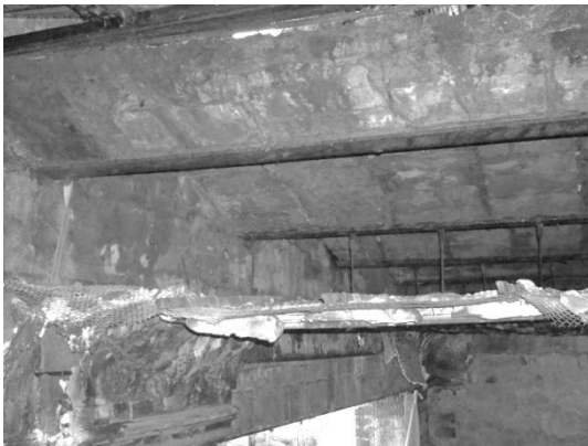
[23. Fotografía del entrepiso bóveda de ladrillo, edificio Gregoire de Wollant]
