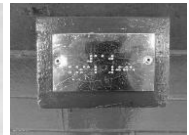
FIG. 105 Comunicación. Placa en braille para informar al usuario.
