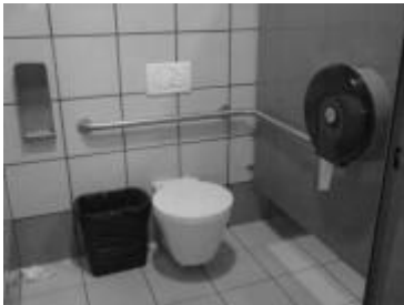
FIG. 61 Sanitario para personas con discapacidad motriz. Los accesorios tienen sensores de movimiento, puede ser más costoso en un principio pero evita adecuaciones posteriores que generen un gasto mayor.
