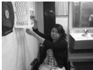
FIG. 103 Uso. Secador de manos al alcance del usuario de sillas de ruedas
