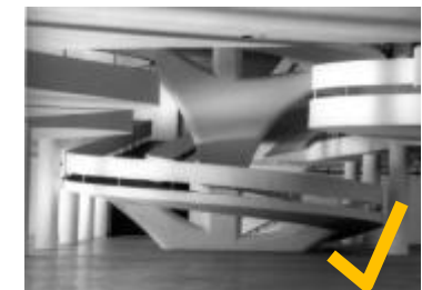
FIG. 24 Rampa helicoidal para circulación interior.
