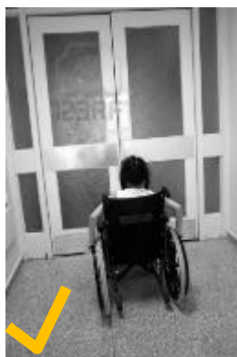
FIG. 26 La puerta es abatible y tiene la protección de rodapie estipulada de 0.20m.
