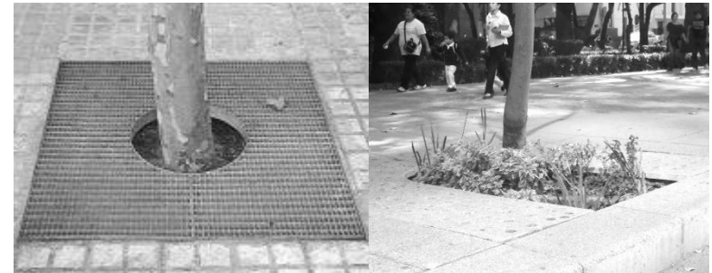
FIG. 177 Protección de alcorques con rejilla.
