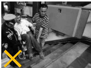
FIG. 43 A pesar de tener el mecanismo de plataforma, la falta de mantenimiento provoca su anulación de uso.
