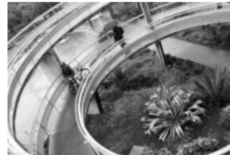
FIG. 62 Rampa para ingresar al transporte público, su diseño helicoidal le da estética, sin embargo, sus pendientes son variadas durante su desarrollo.
