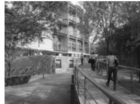
FIG. 63 Rampa para ingresar al la Torre de Ingeniería. C. U. México, D.F.
