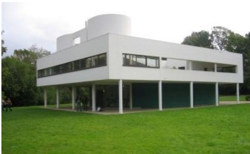
Imagen 49. Fachada suroeste de la Villa Savoye donde se eleva el volumen para darle autonomía del terreno al estar sobre pilotis
