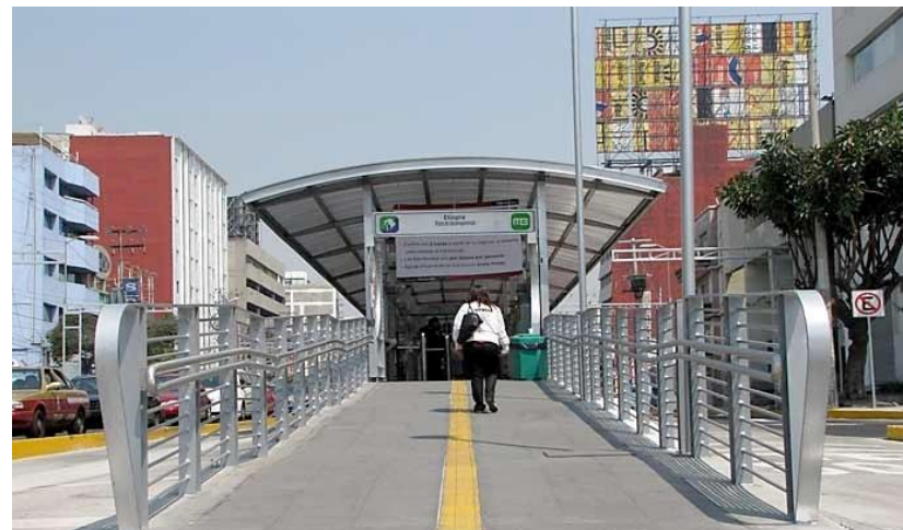
Imagen 23. Rampa de acceso a estación del Metrobús Etiopia que cuenta con guía táctil para las personas con discapacidad visual.
