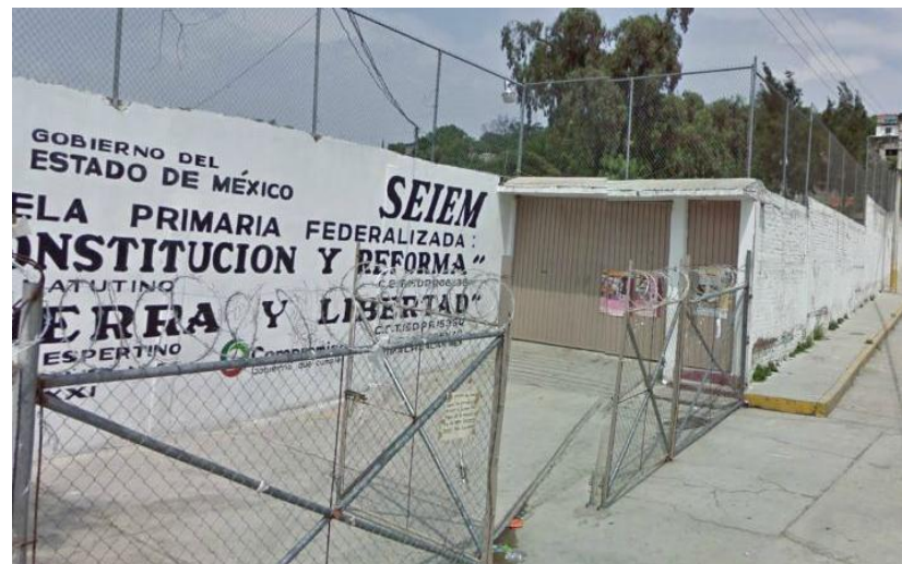
Foto 1. El acceso principal cuenta con una rampa de ascenso y descenso para el ingreso de la silla de ruedas. El ancho de la puerta permite un desplazamiento libre.
