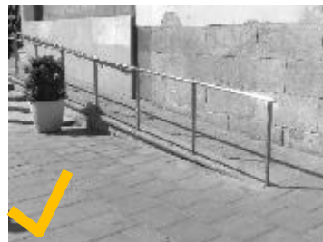
FIG. 38 Rampa con las medidas de seguridad y pendiente adecuada.
