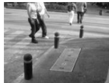
FIG. 164 Se deben colocar los bolardos mínimo a 90 cm de distancia entre ellos
