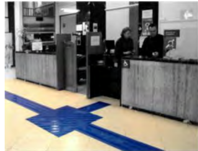
FIG. 147 Franja de encaminamiento, contrastada en color y textura, que recorre desde la entrada y se transforma en un nodo para indicar un cambio de dirección que dirige al mostrador de atención al público.
