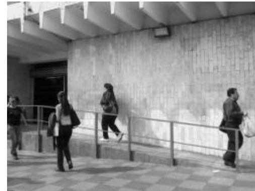
FIG. 56 Barreras laterales en rampa para acceder.
