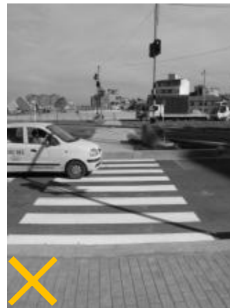
FIG. 30, 31 Las fotografías muestran la falta de cultura de accesibilidad al espacio urbano. Arriba: bloqueo en rampa. Derecha: paso peatonal sin rebajes.
