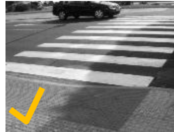
FIG. 32 Paso peatonal continuo.
