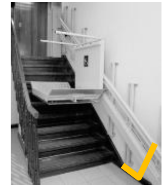
FIG. 22 Uso de plataforma para circulación interior vertical.
