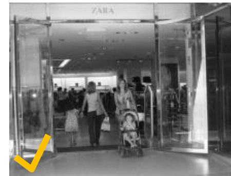
FIG. 4 Al tener un solo nivel de piso y puertas corredizas aseguran una integración al tránsito peatonal segura y autónoma.
