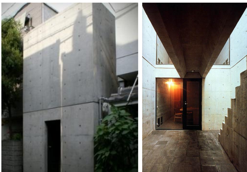
Imagen 59. Row House. Vista de la fachada de hormigón de la casa que muestra una sola abertura, la entrada.
