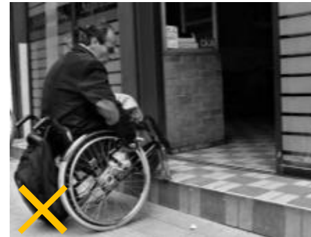
FIG. 3 Dificultad que tienen las personas con discapacidad motriz para ingresar a un local.
