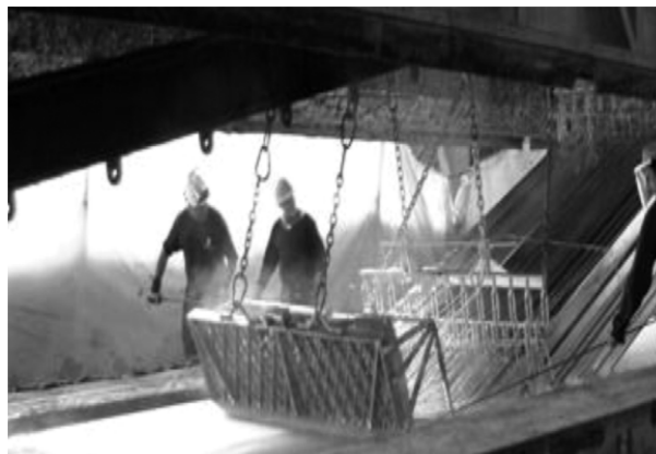
Figura 1.3. Proceso de galvanizado en caliente para grandes perfiles estructurales [3]
