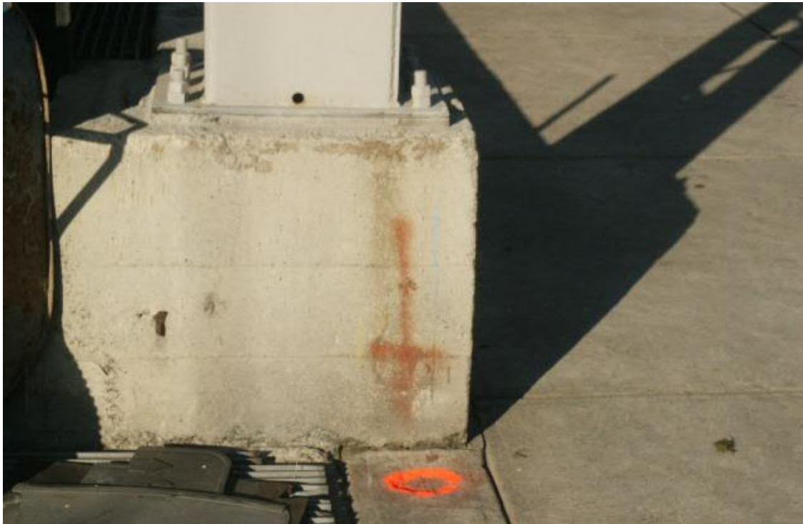
Fotografía 3 Banco de nivel oficial P(S05-E07)02.
