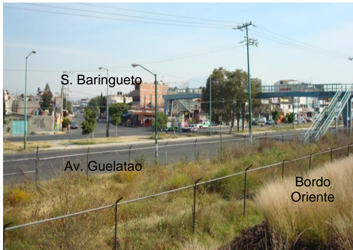
ASPECTO GENERAL DE VIALIDADES
