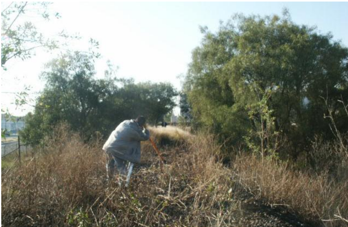
Fotografía 4 Aspecto general de los trabajos de nivelación sobre el bordo oriente de la Laguna Mayor de Iztapalapa.
