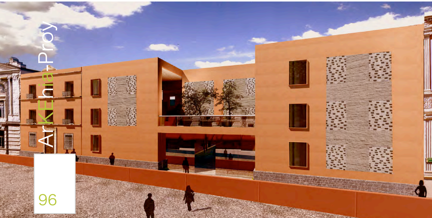
FIG 72.. Fachada de ARKehIA. Centro de Documentación y Biblioteca Especializada en Arquitectura.
