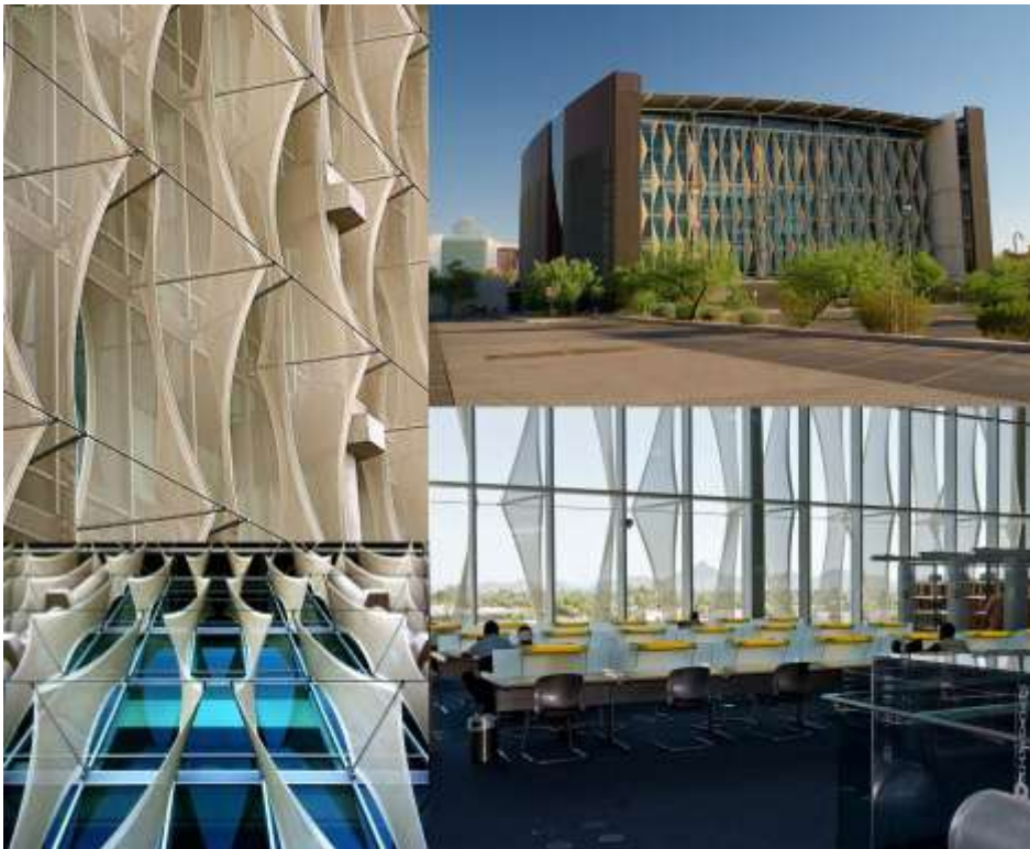
Imagen 45. . Parasoles Verticales como elemento de control solar a base de tensoestructuras diseñadas por Nicolas Goldsmith, para Burton Barr Central Library, en Phoenix Arizona. Fuente: Arq. E.C.L. Marcos Javier Ontiveros Hernández
