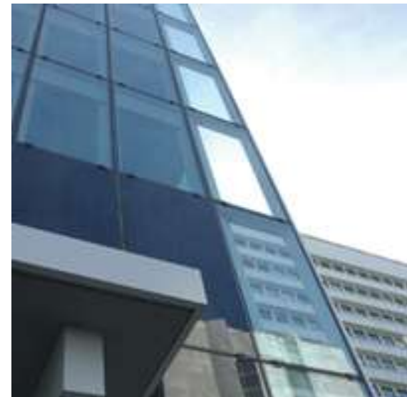
Imagen 17. Vidrio de tipo Low E, de baja emisividad. Es un vidrio altamente selectivo, combinando bajo factor solar y alta transmisión luminosa. Su alto poder de control garantiza mayor economía de energía, reduciendo el uso del aire acondicionado. Fuente: http://www.vidrioandino.com
