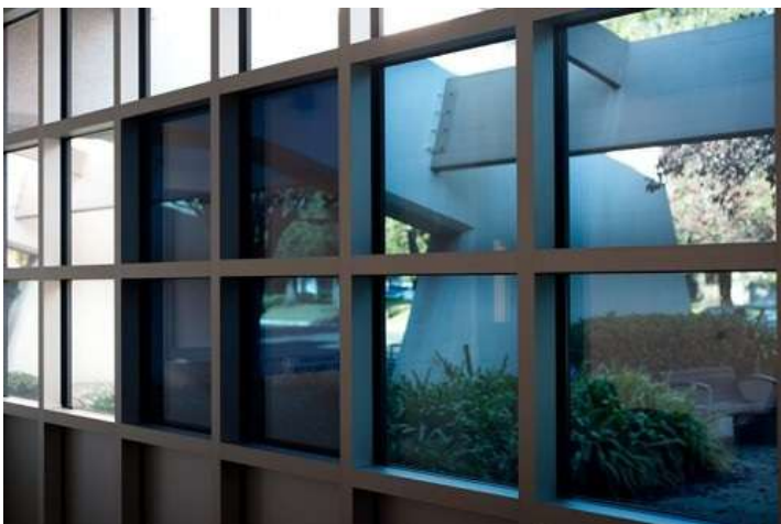
Imagen 19. El vidrio electrocromático es un vidrio laminado capaz de tornarse opaco mediante la aplicación de una corriente eléctrica.
