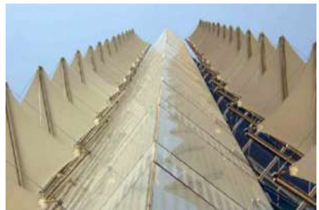
Imagen 15. Utilización de parasoles, como elemento de control térmico en el edificio Corporativo Insurgentes 553. Fuente: www.picciotto.com
