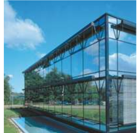
Imagen 16. Vidrio tipo Reflectivo Cool Lite. Rendimiento diferenciado para control solar en la transmisión y reflexión de luz y calor, además de un bajo coeficiente de sombra. Fuente: http://www.vidrioandino.com
