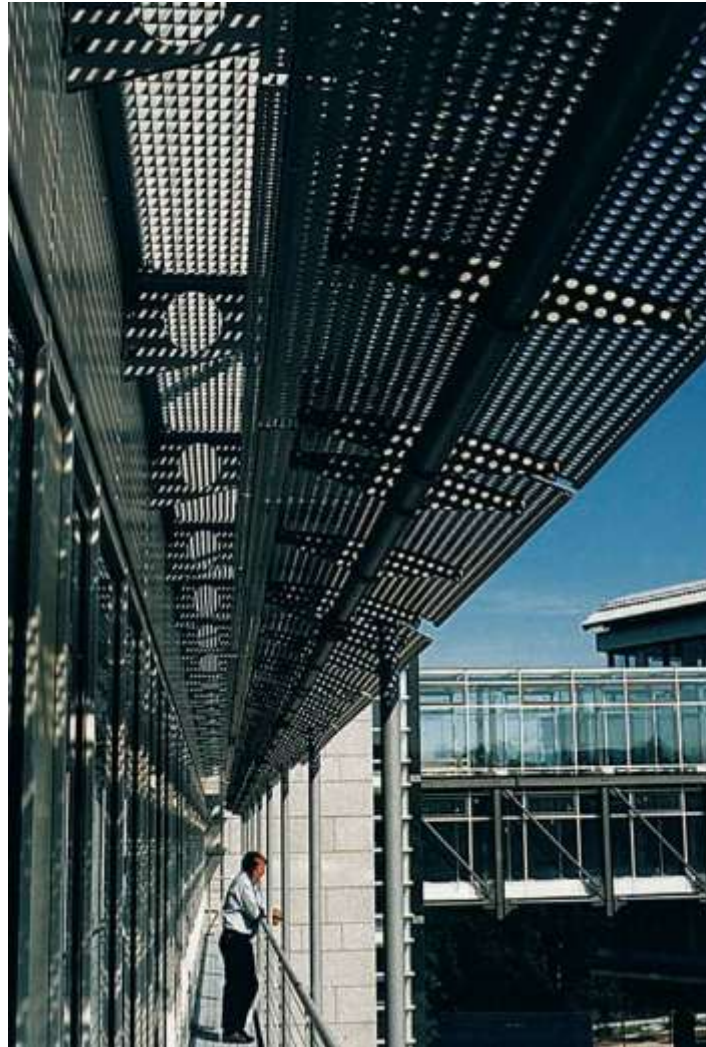
Imagen 47. Parasoles modelo Airlux de las Industrias Parrar, a base de aluminio lacado con perforaciones, mismas que impedirán la ganancia solar por radiación al interior del edificio. Fuente: http://www.industriasparra.es
