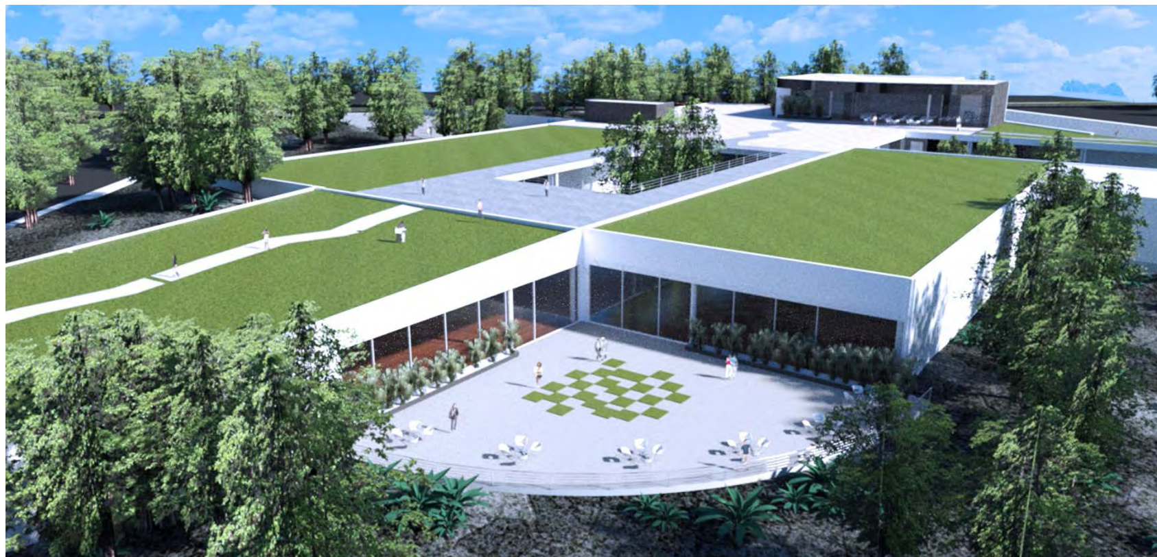
Figura 6.2.3 Vista sur del conjunto arquitectónico “Museo del Agua”
