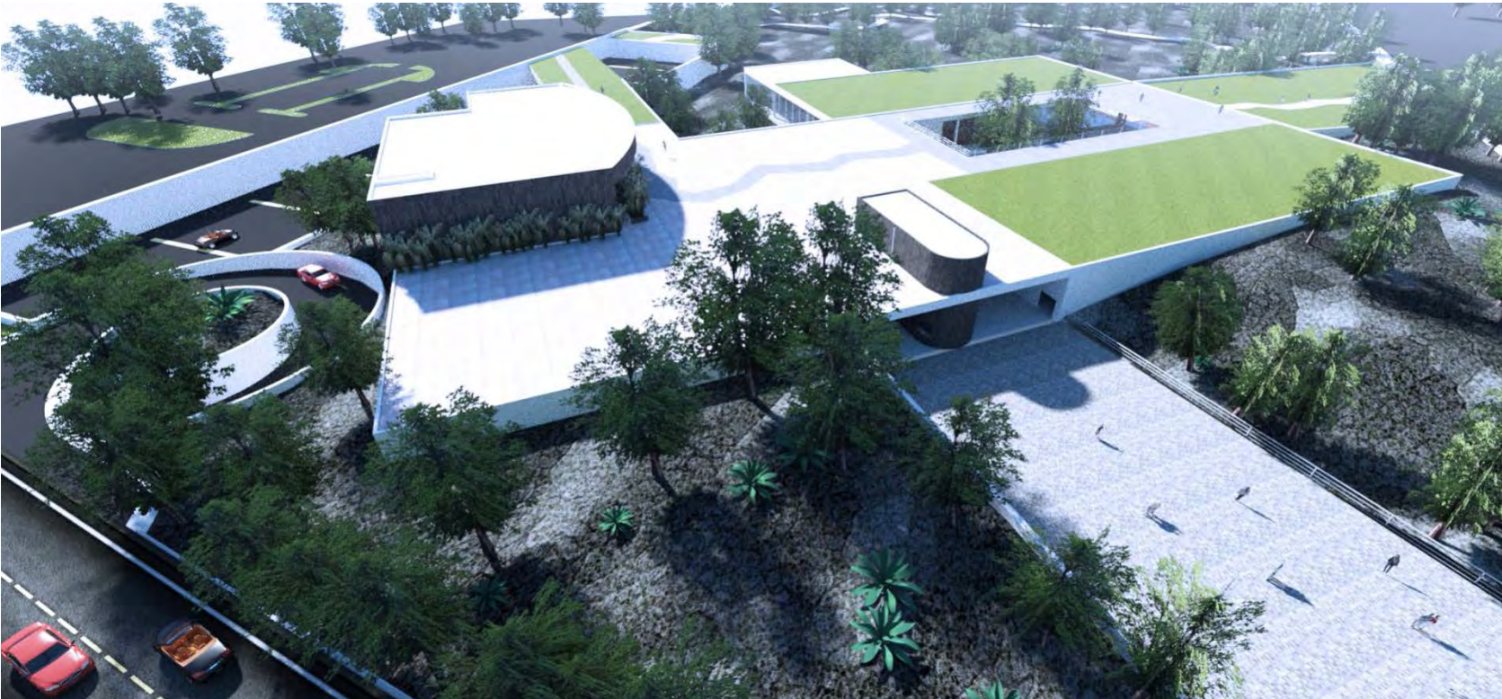
Figura 6.2.2 Vista norte del conjunto arquitectónico “Museo del Agua”
