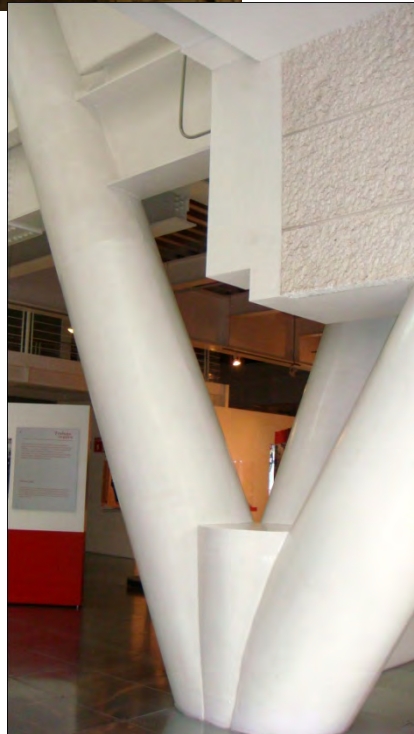
Figura 2.2.2.19 Estructura de acero ala izquierda
