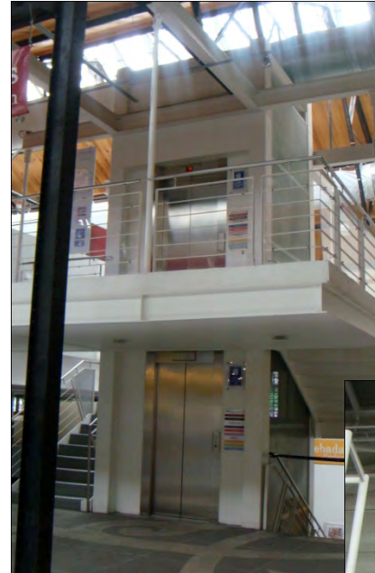
Figura 2.2.2.17 Cubo de elevadores
