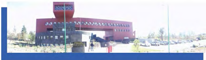
Figura 5.1.1.1 Nuevo Edificio de Economía
