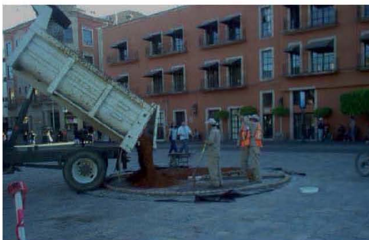
Figura 3.23 Vaciado de la tierra.
