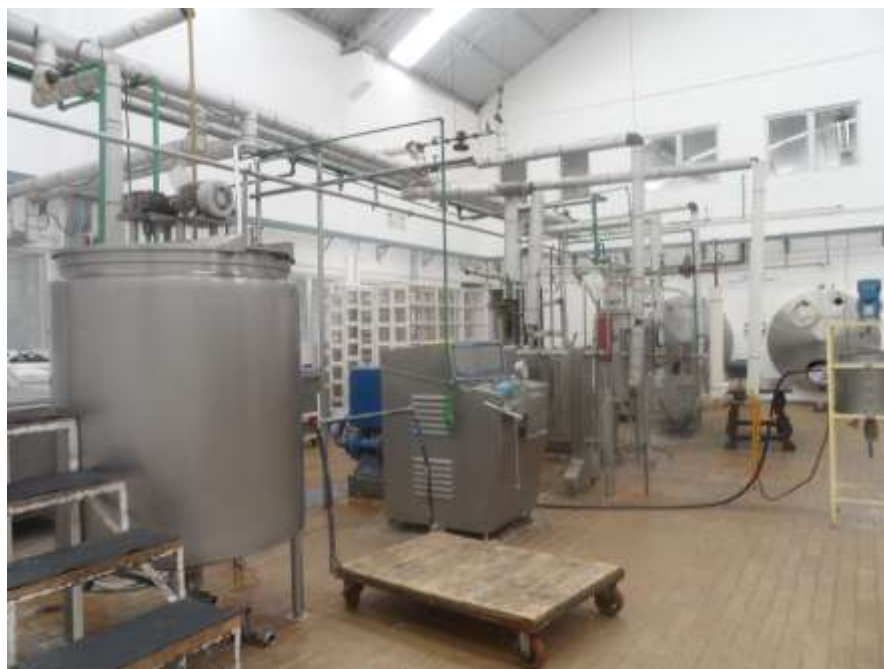
Figura 1. Imagen del interior de la Unidad de Tecnología Lechera de la UACH, 2012.
