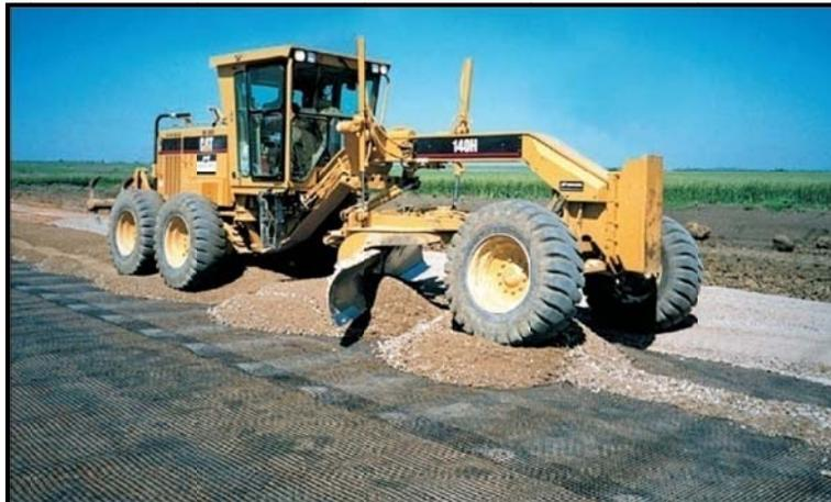
**Imagen 5.3** Tendido con motoconformadora del centro hacia los hombros de la calzada.
