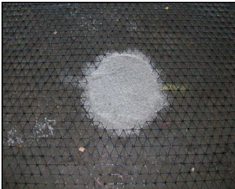
**Foto 4** Medidores instalados fueron cubiertos con arena para evitar daños.
