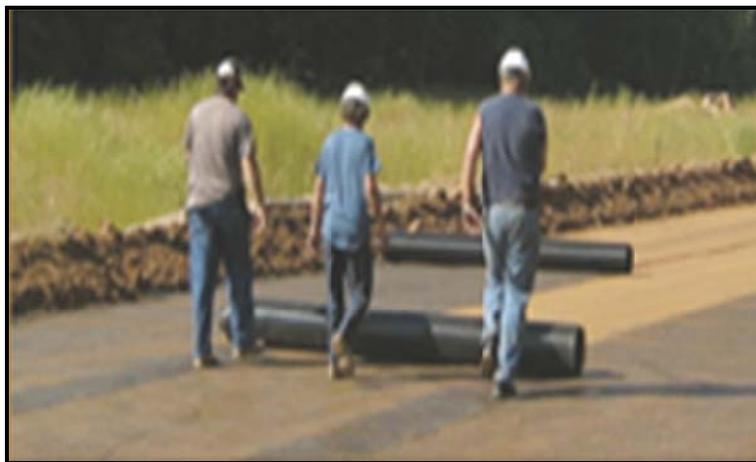
**Imagen 5.1** Tendido a mano de geomallas; para reforzar subrasante. Se observa la superficie plana.
