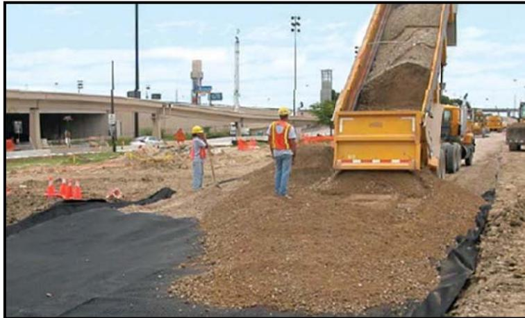
**Imagen 5.2** Descarga de material, se observa que el transporte no toca el geosintético.
