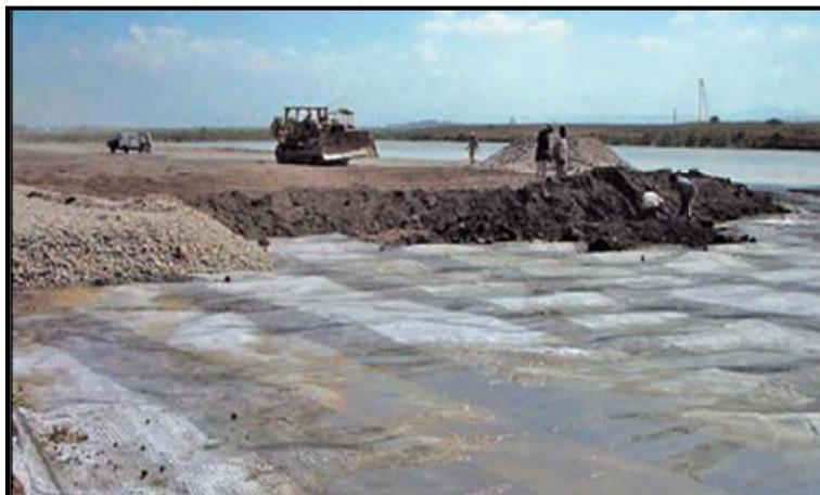
**Imagen 5.4** Extendido de relleno sobre geomalla con tractor.
