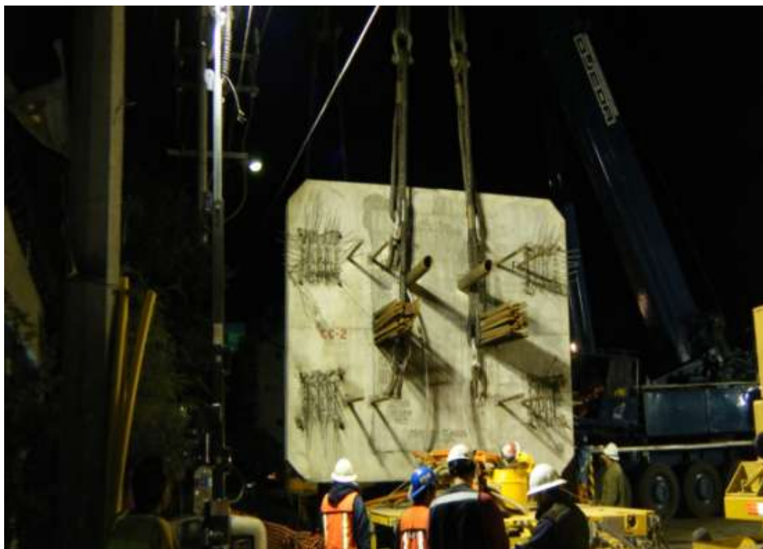
Figura 57. Ganchos de izaje de columna en capitel.
