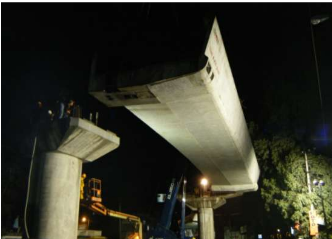
Figura 69. Izaje de trabe a los puntos de apoyo.
