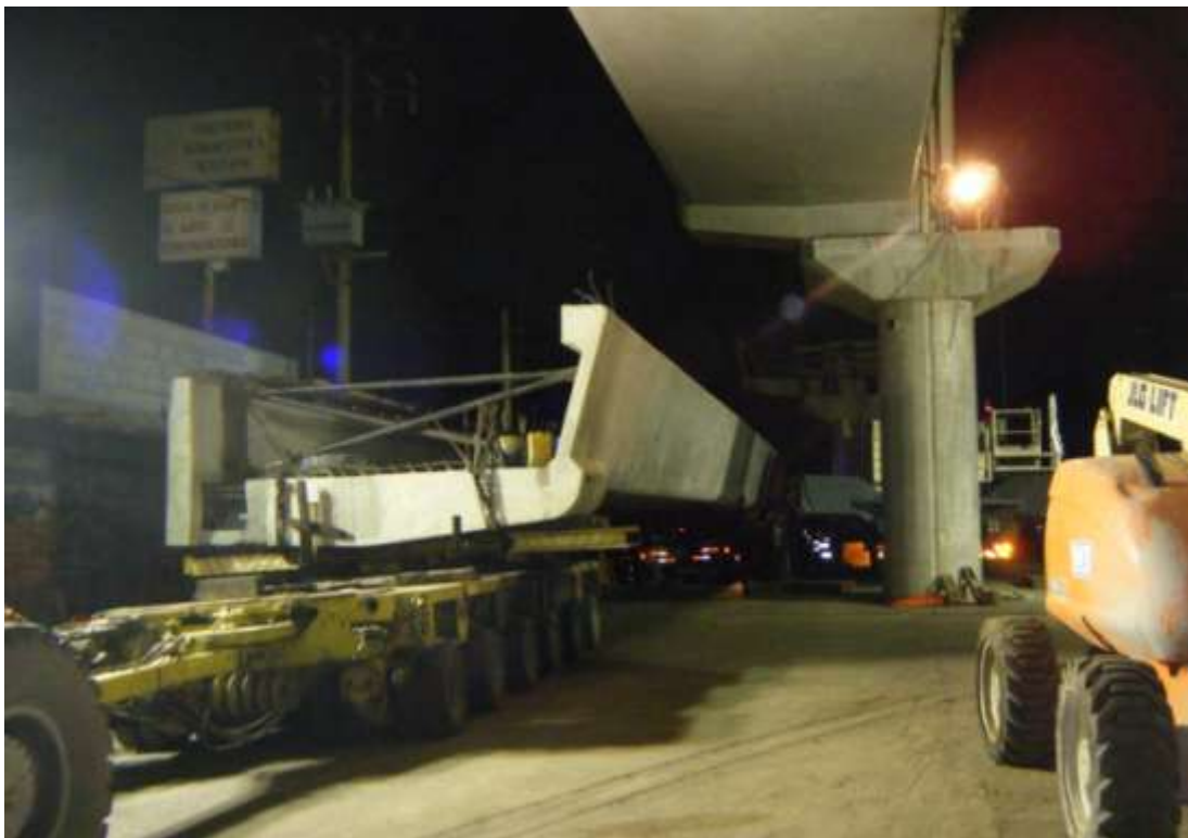
Figura 66. Llegada de la trabe prefabricada al sitio de montaje.
