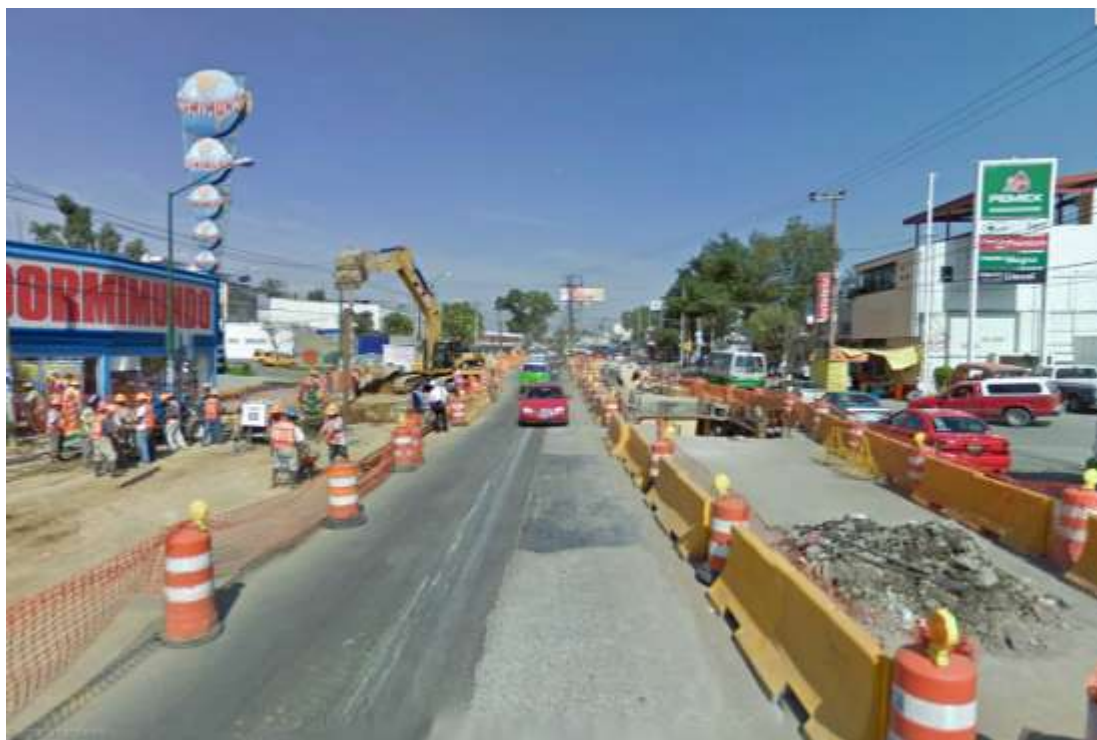
Figura 15. Desvío de colector de Ø72”.
