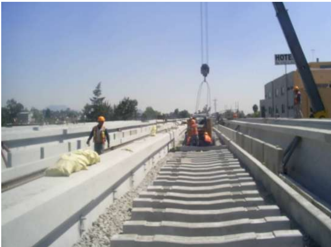
Figura 83. Descarga y acomodo de durmientes.
