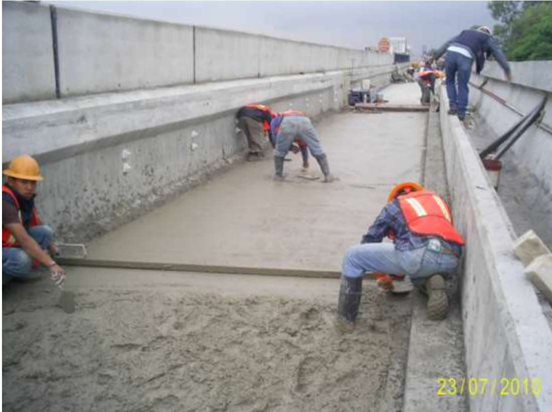
Figura 80. Aplanado de firme para dar pendiente.
