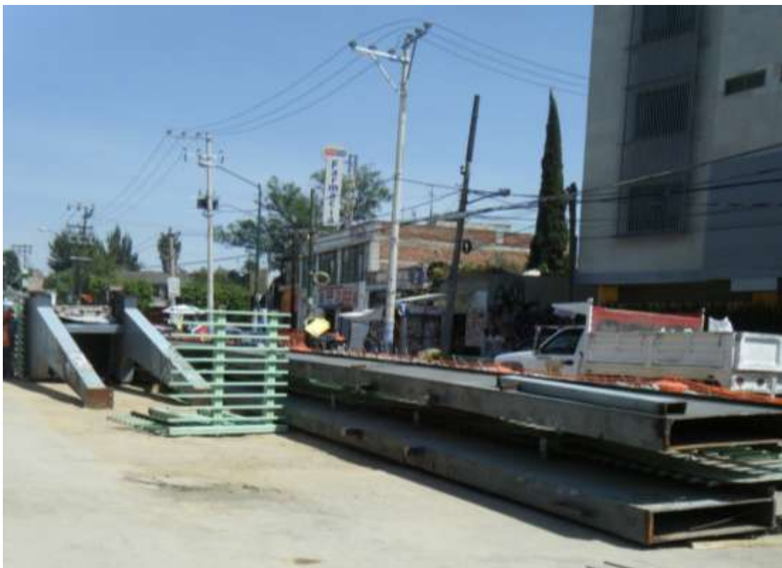
Figura 14. Puente peatonal retirado.
