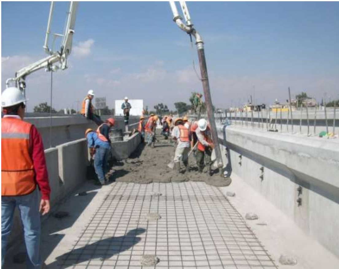
Figura 79. Colado de firme nivelador.
