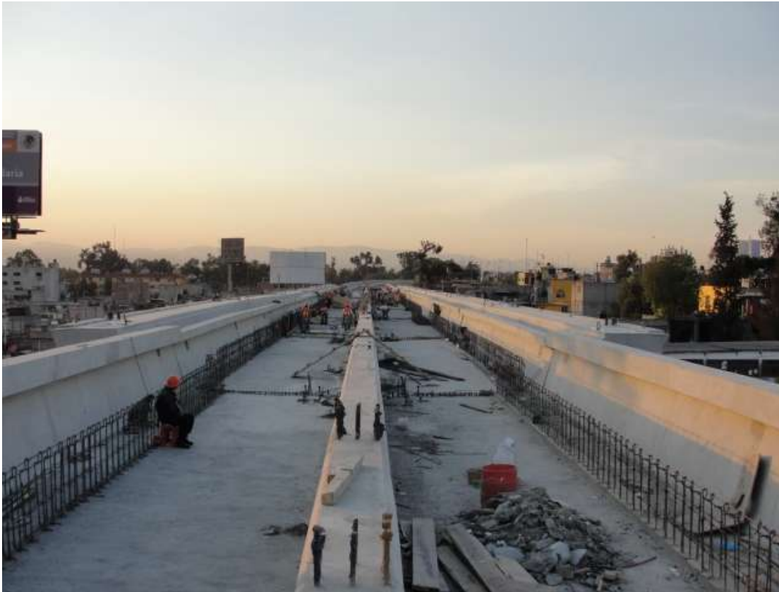
Figura 76. Vista de bulbo terminado.
