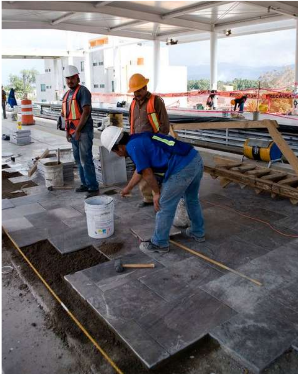
Figura 28. Colocación de mármol tipo Santo Tomás en pisos de andén.
