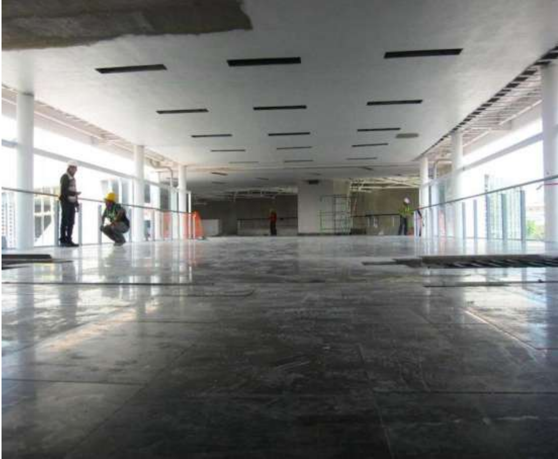
Figura 33. Preparaciones en plafón para luminarias en pasarela de estación.
