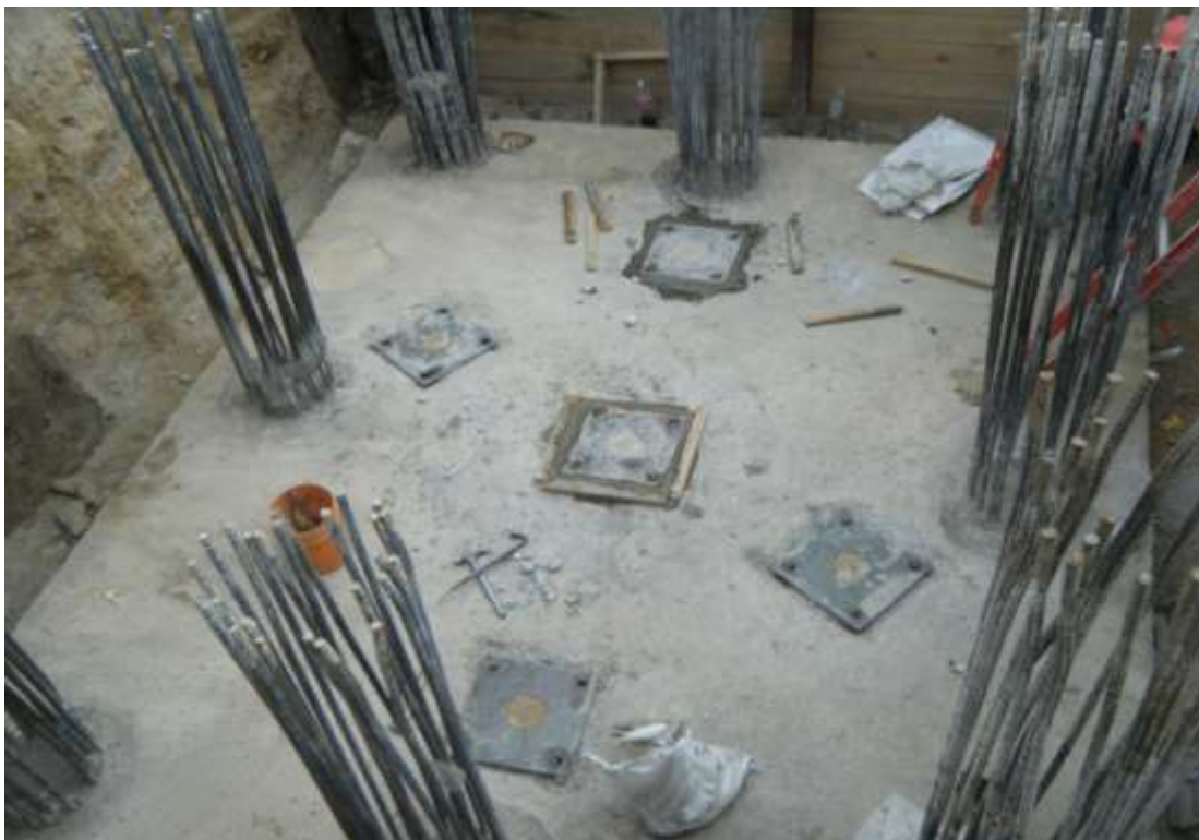
Figura 52. Colocación de placas de acero para nivelación de columna.
