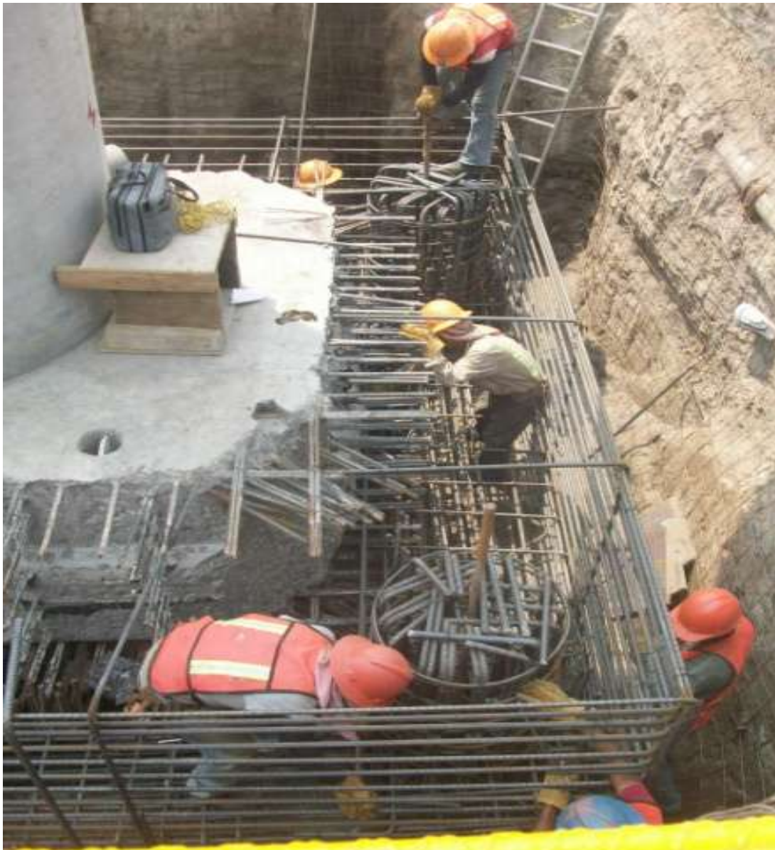
Figura 62. Armado de la conexión de zapata.
