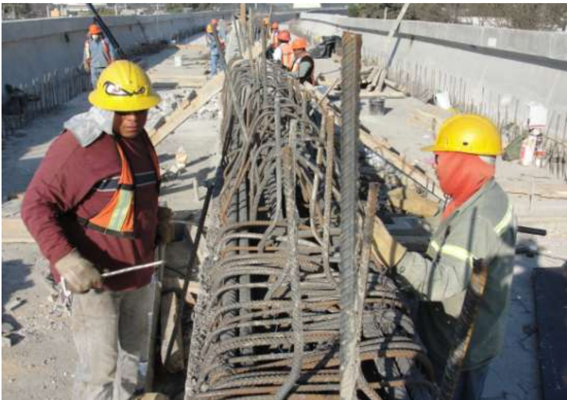
Figura 75. Armado de bulbo superior.
