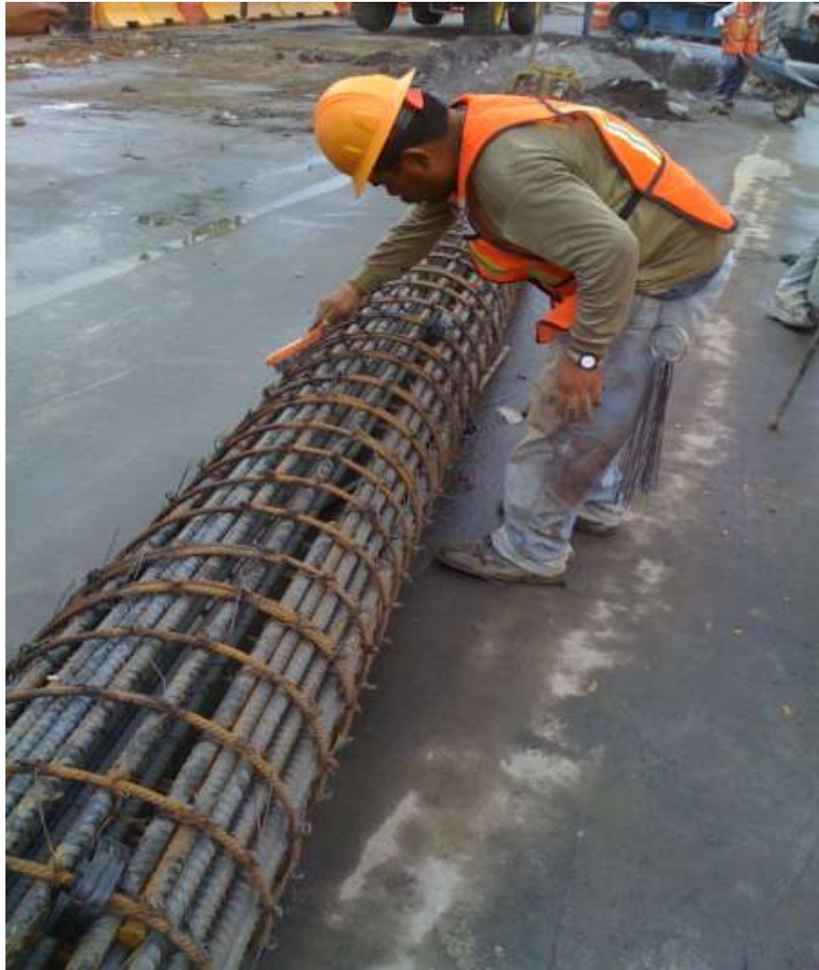
Figura 46. Limpieza de acero en pilas.
