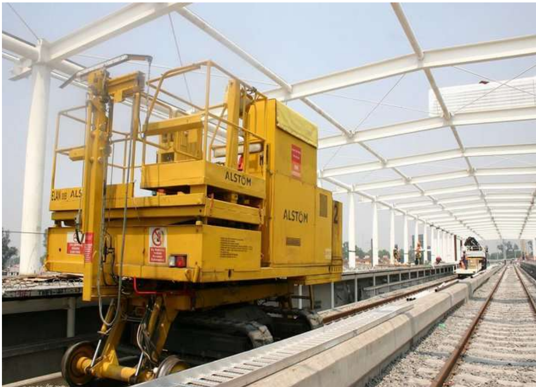
Figura 86. Alineación y nivelación de vías.
