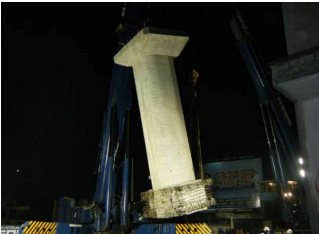
Figura 60. Columna sobre apoyo.
