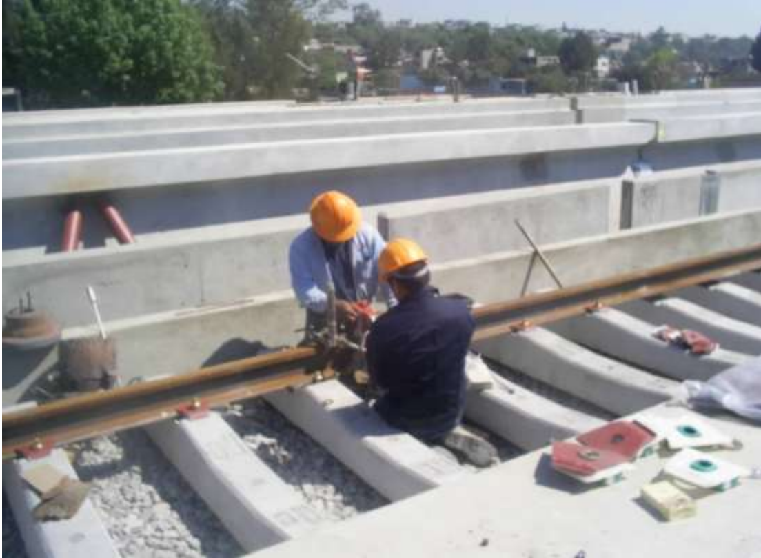
Figura 85. Soldadura aluminotérmica en rieles.
