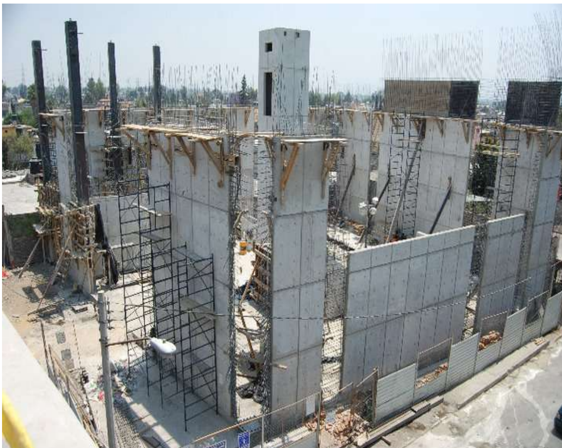
Figura 29. Muros de concreto aparente en accesos de estación.
