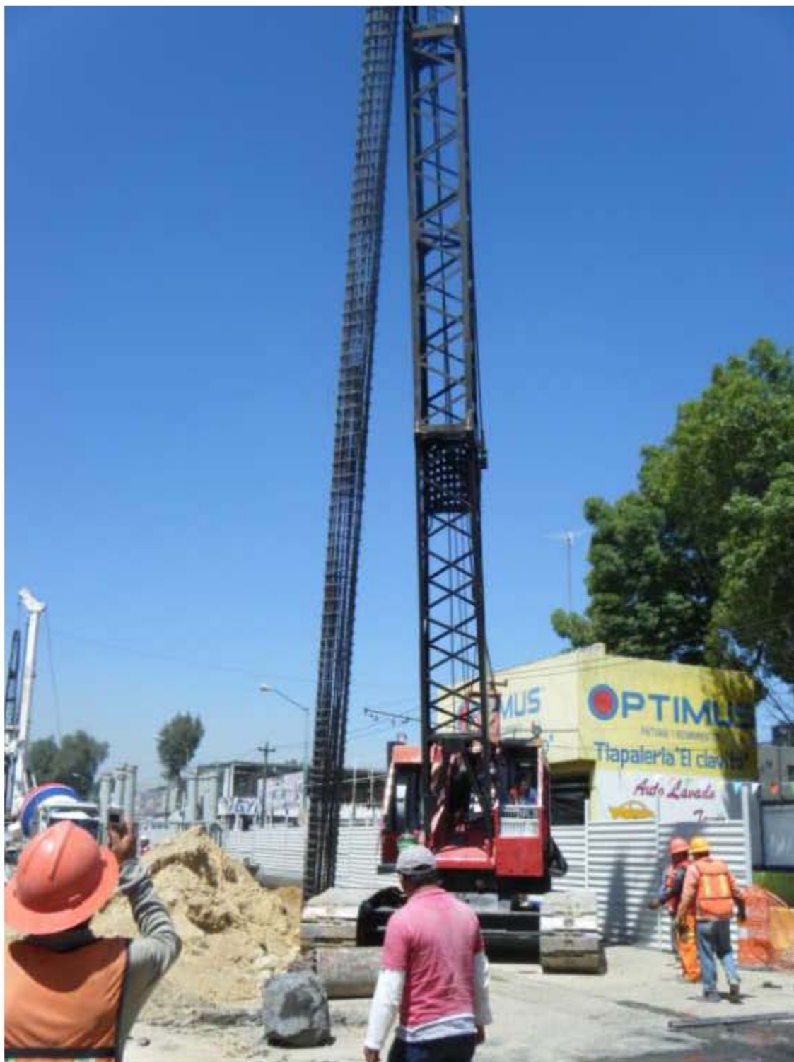
Figura 47. Izaje del armado de una pila.
