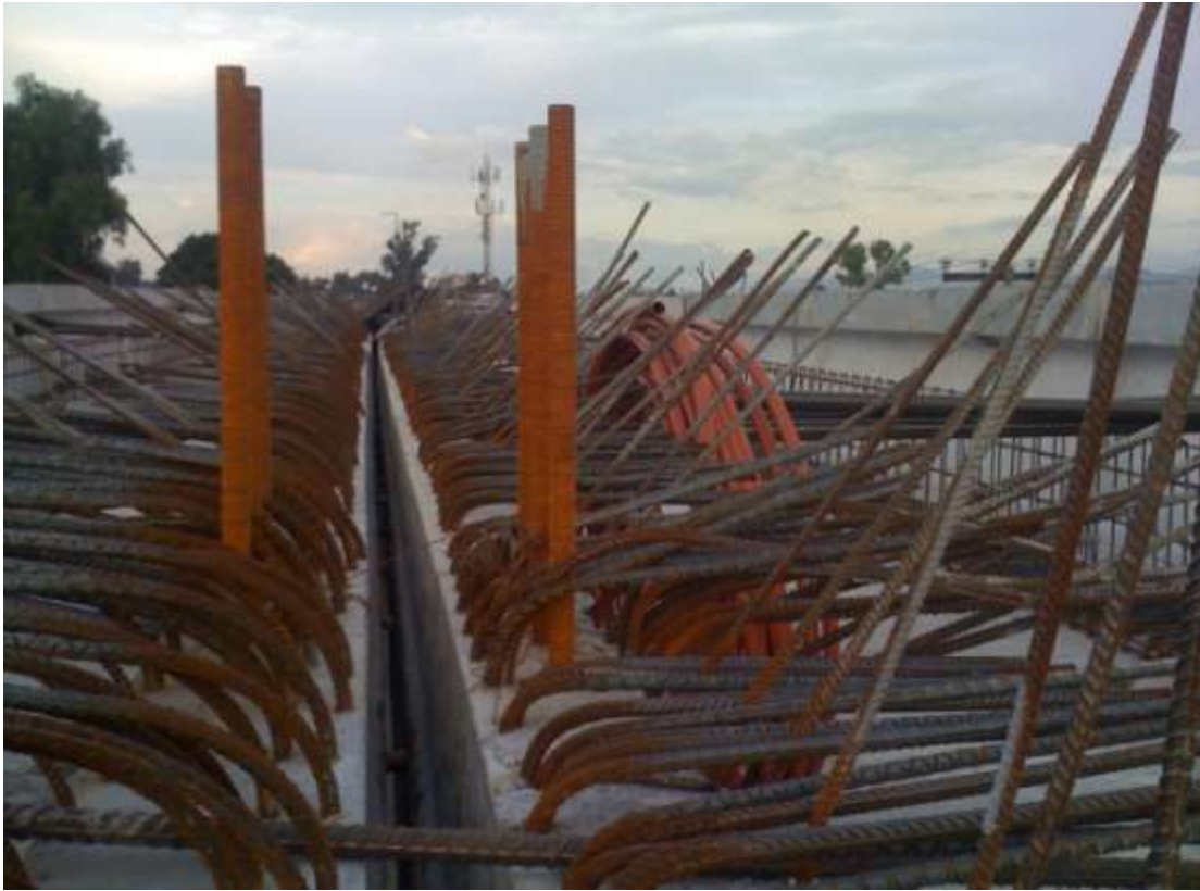
Figura 74. Varillas para armado de bulbo superior a lo largo de las trabes.
