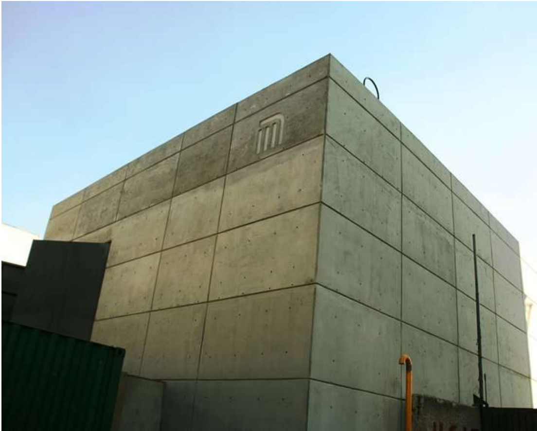
Figura 30. Muros de concreto aparente en subestación de rectificación.
