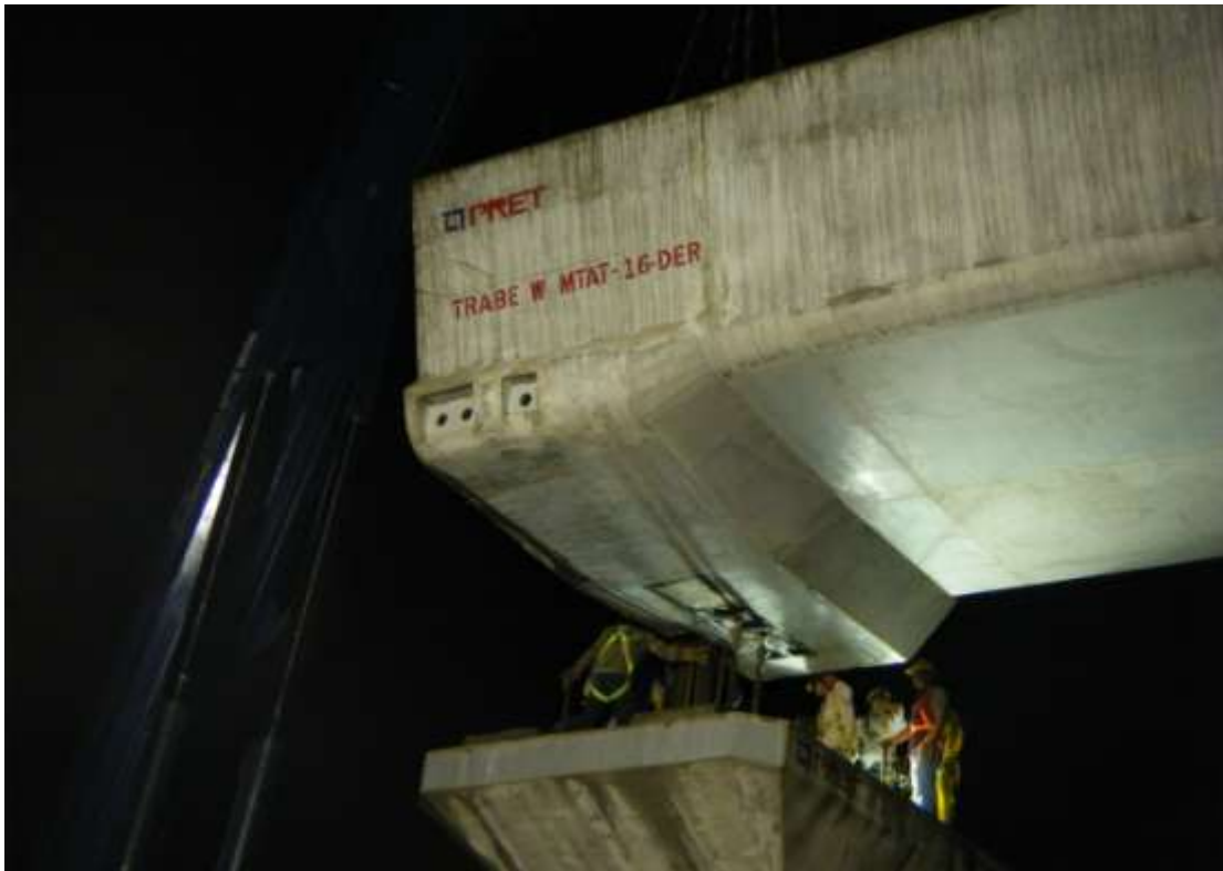
Figura 70. Ensamble de columna con trabe.
