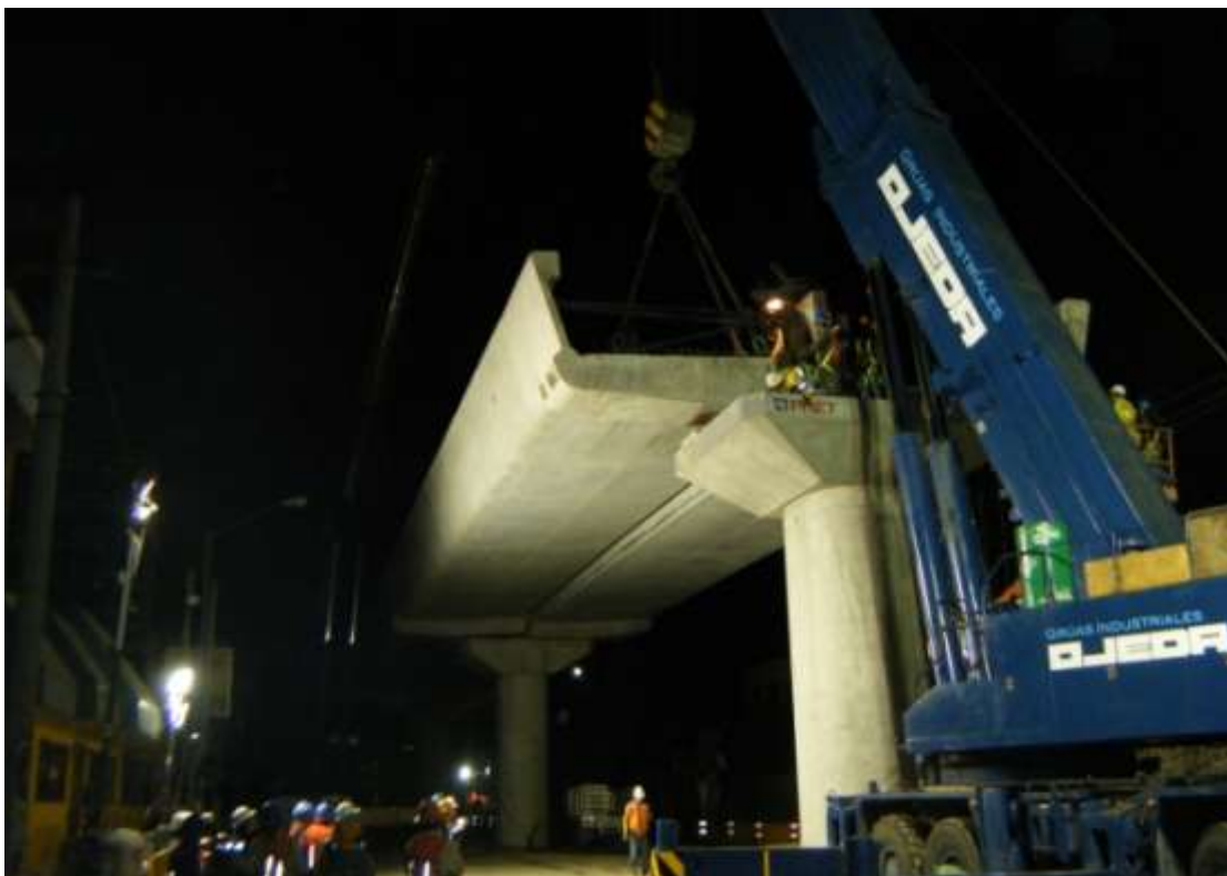
Figura 71. Montaje de traves finalizado.
