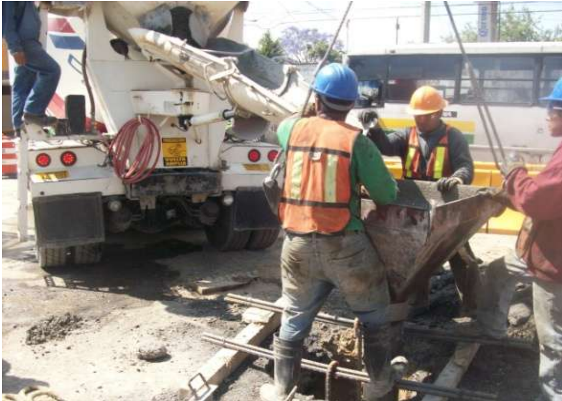
Figura 48. Colado de pilas con tubería tremie.
