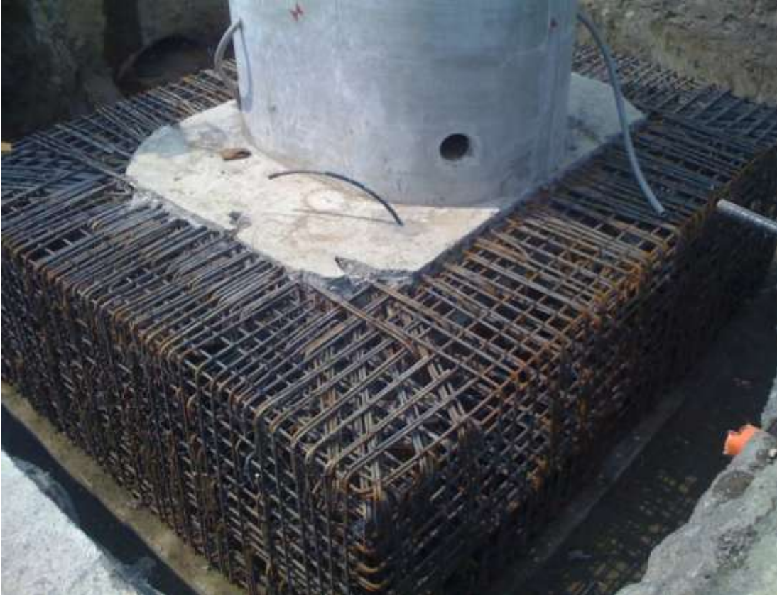
Figura 63. Armado final de la zapata.
