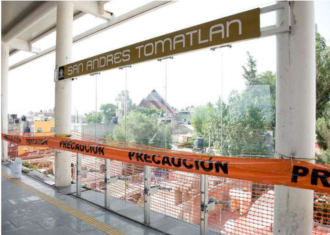
Figura 34. Señalización del nombre de estación.
