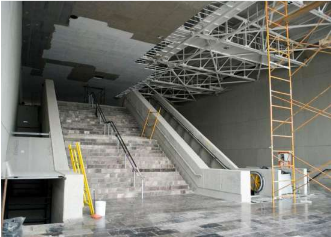
Figura 31. Colocación de plafones en techos.
