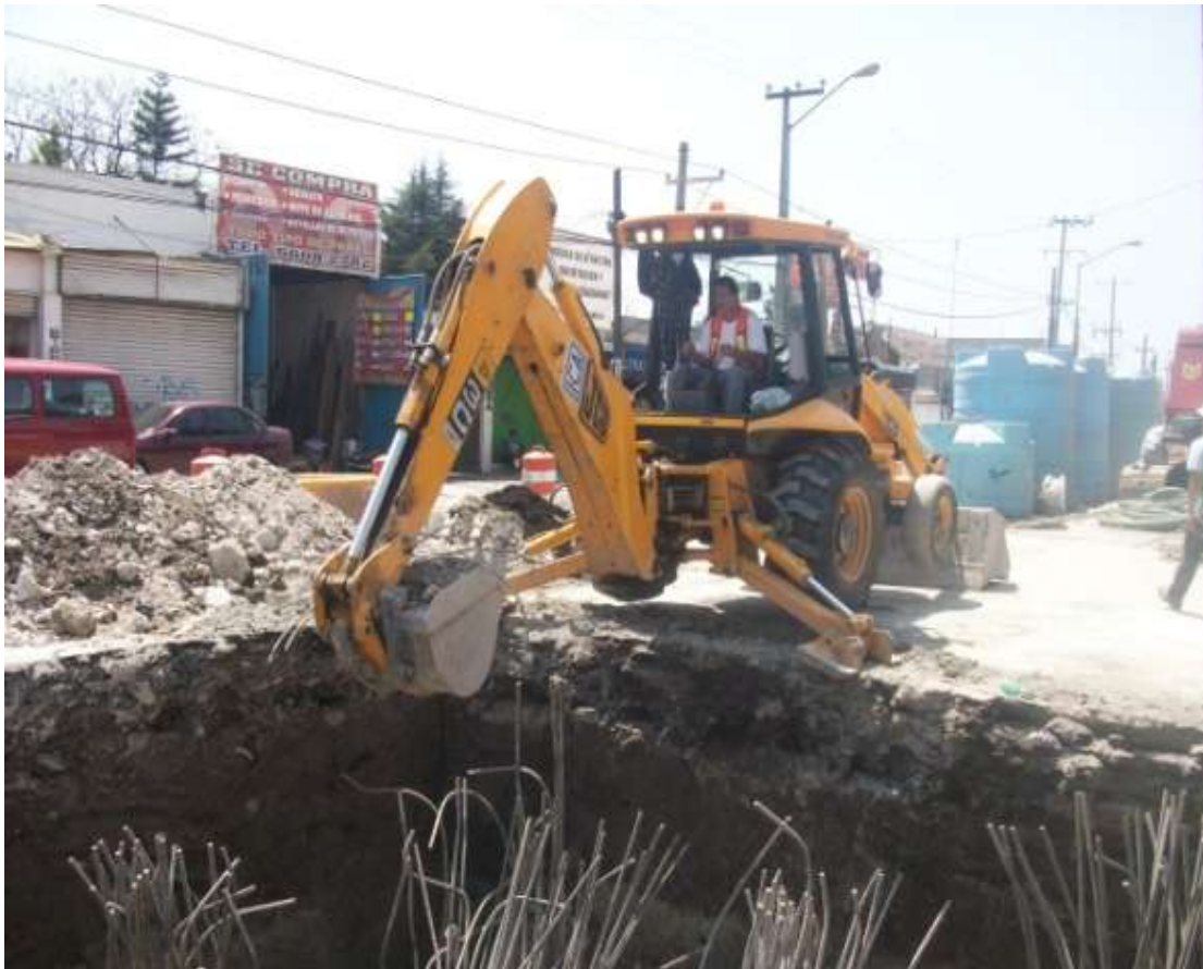
Figura 49. Excavación de zapatas.
