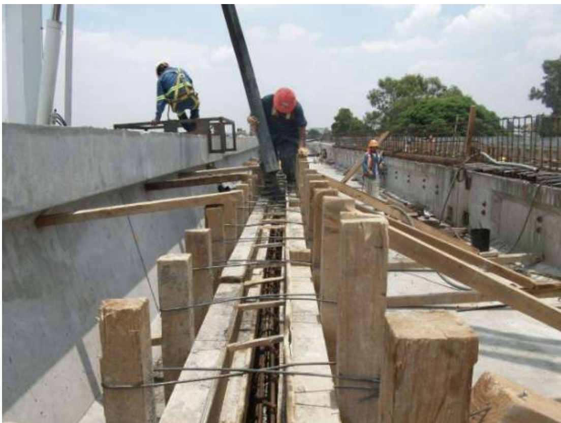
Figura 78. Colado de muro trinchera.
