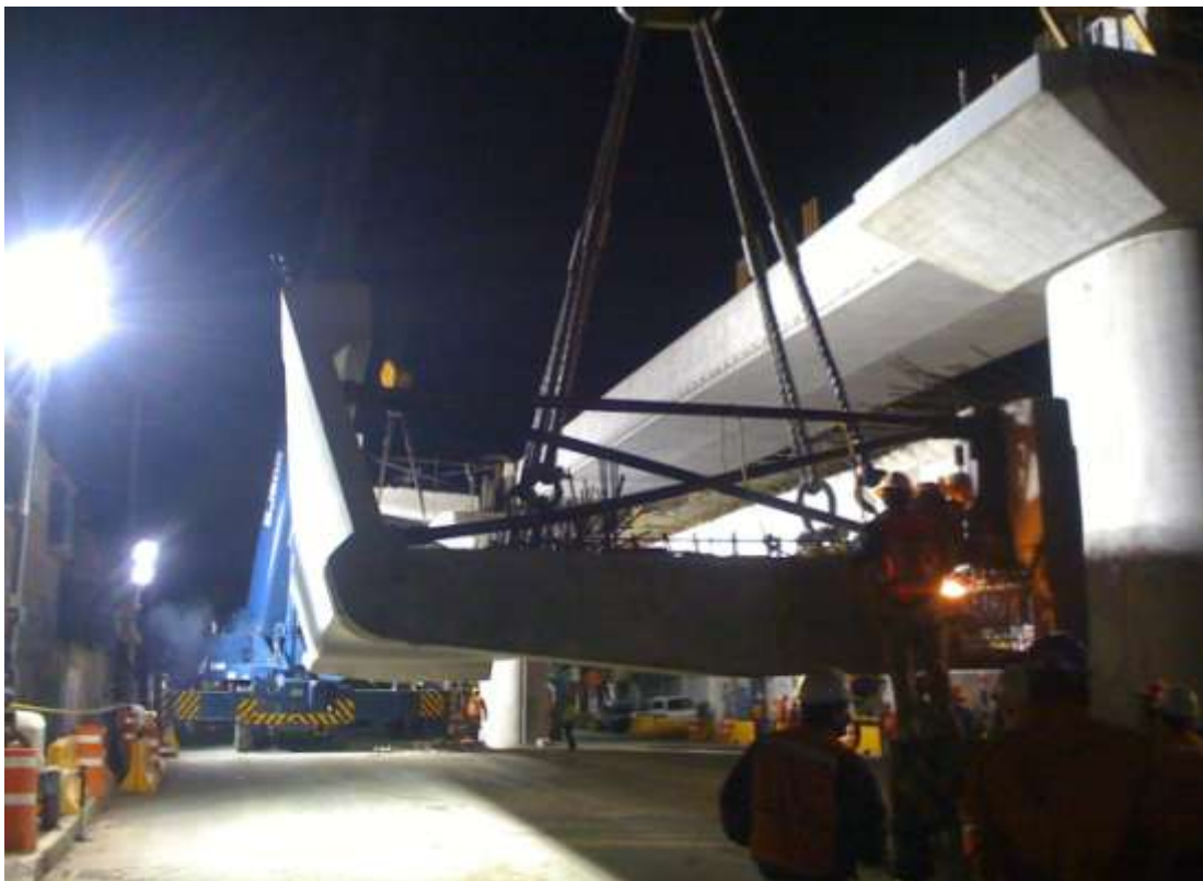
Figura 68. Estrobado de la trabe previo al montaje.
