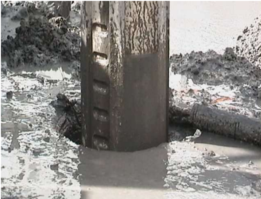
Figura 44. Manejo de lodo bentonítico.
