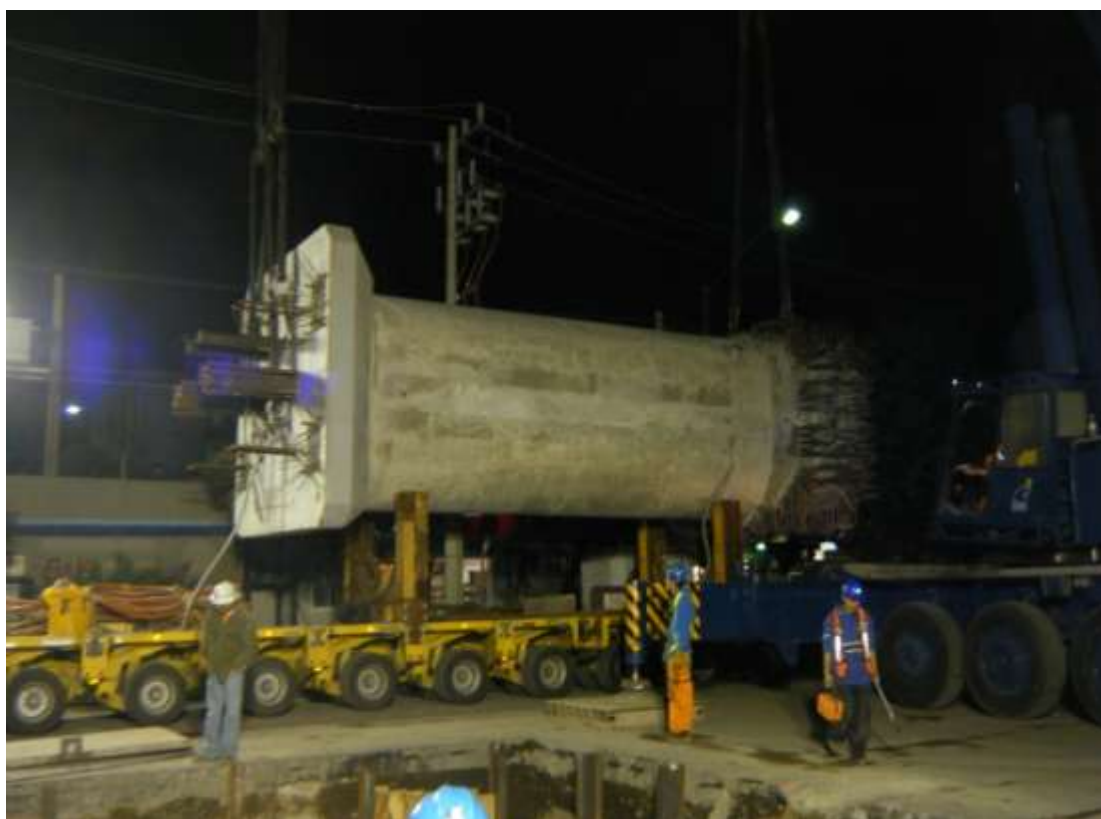
Figura 58. Izaje de columna y retiro de tren de transporte.
