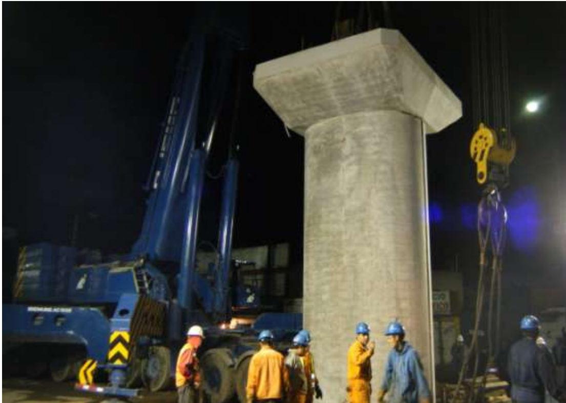
Figura 61. Montaje de columna finalizado.
