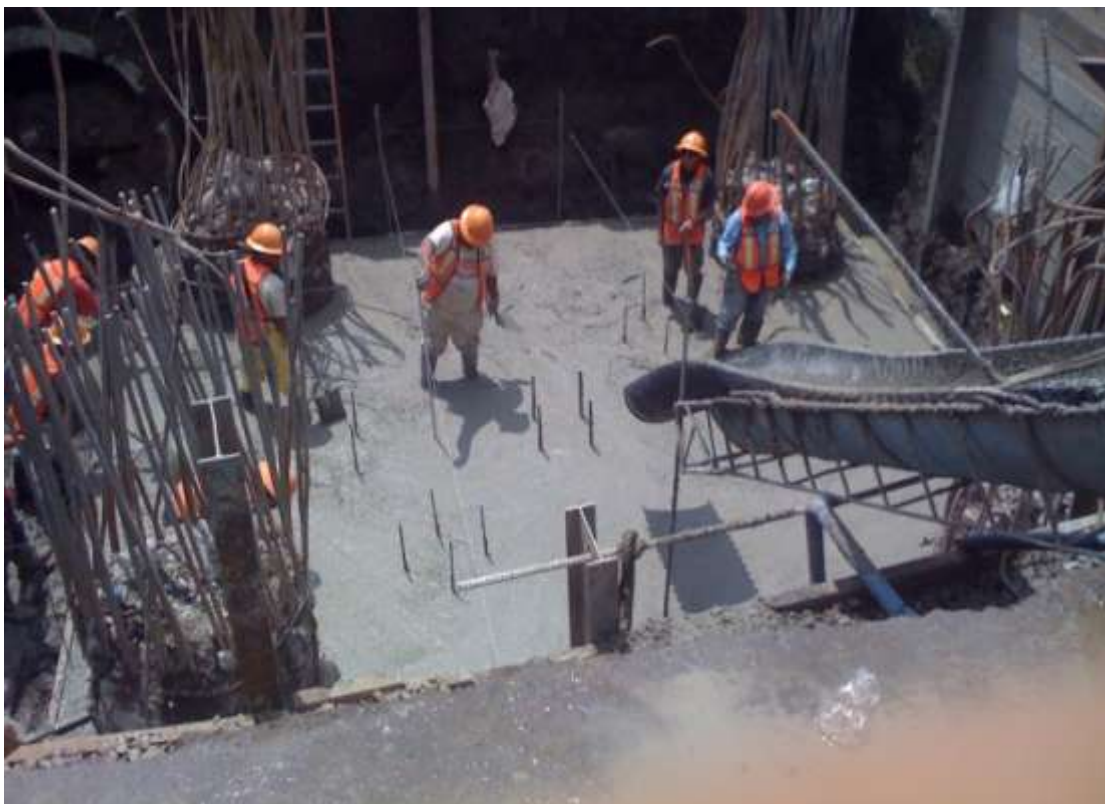
Figura 51. Colado de plantilla armada para apoyo.
