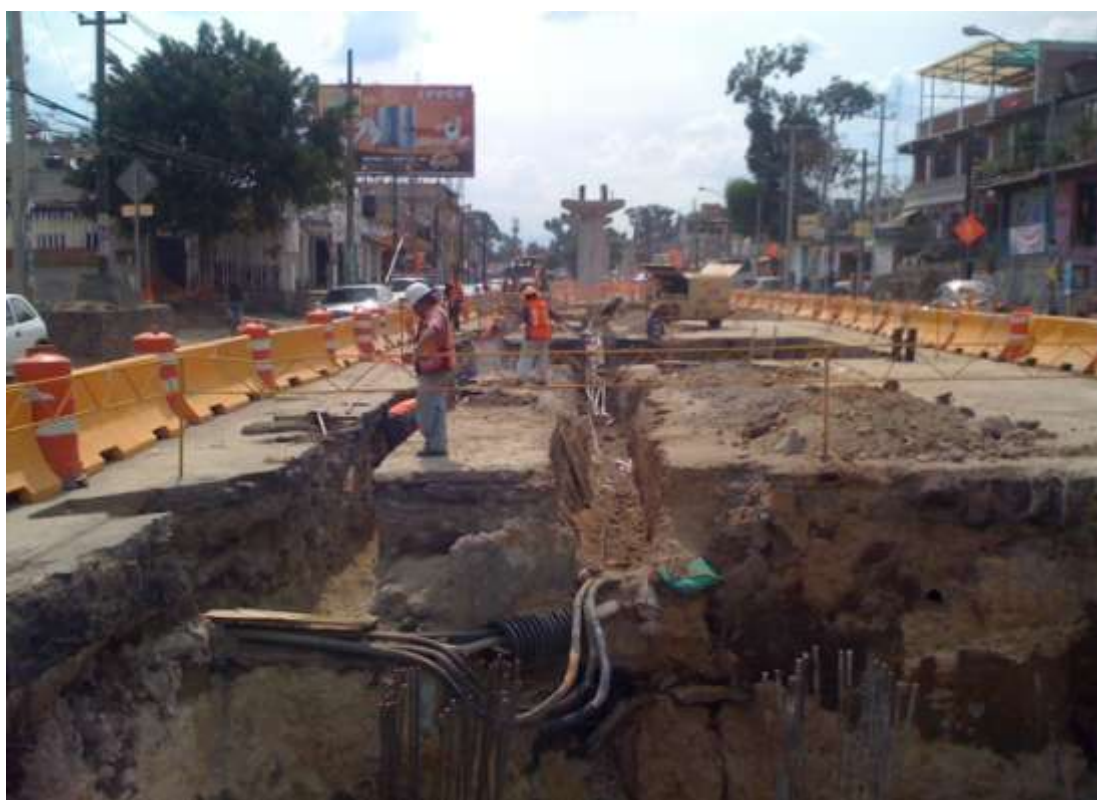
Figura 16. Desvío de ductos de telefonía y fibra óptica.
