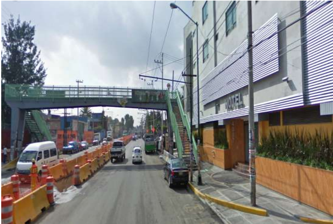
Figura 13. Interferencia de puente peatonal.
