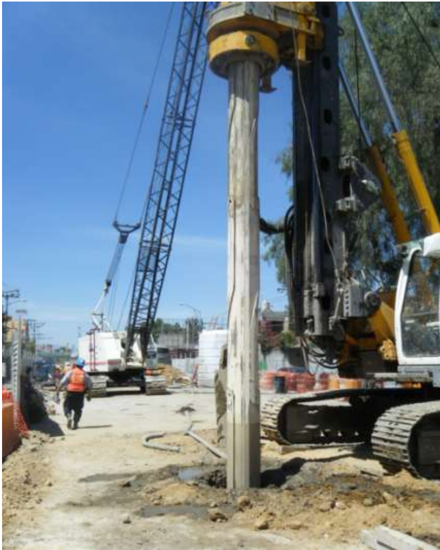
Figura 43. Perforación para pilas.
