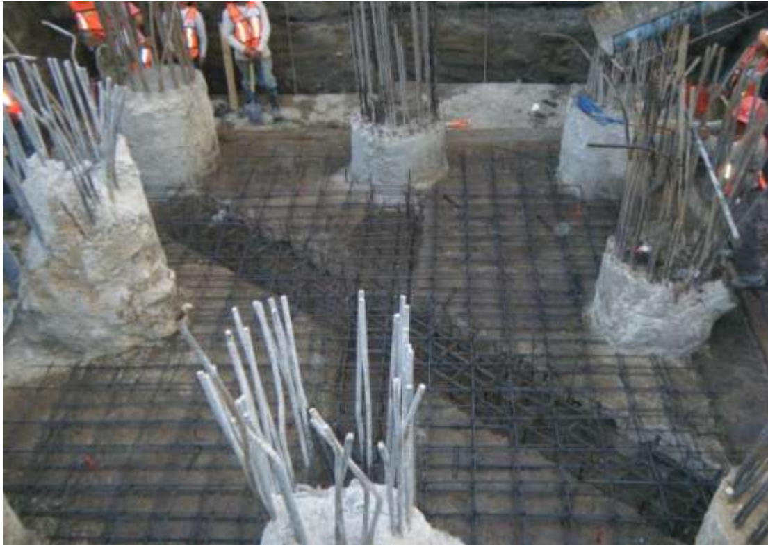
Figura 50. Apoyo con plantilla armada previa al colado.
