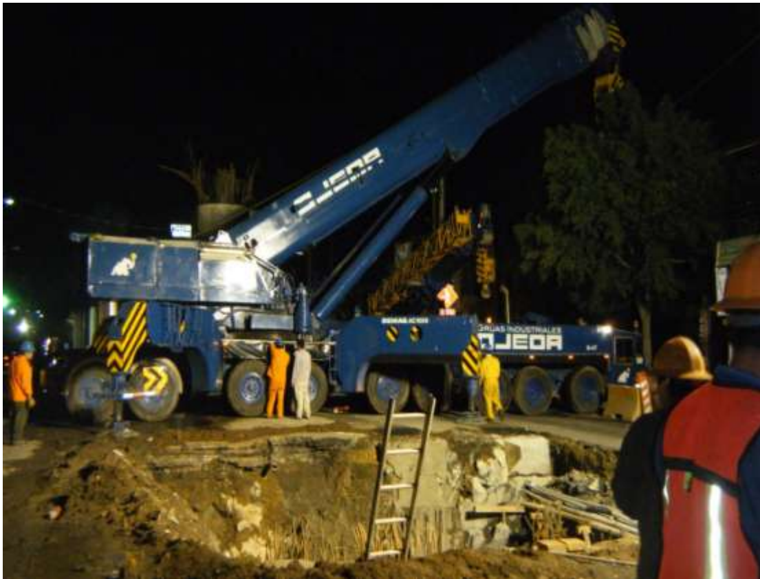
Figura 54. Posicionamiento de grúas previo al arribo del elemento prefabricado.
