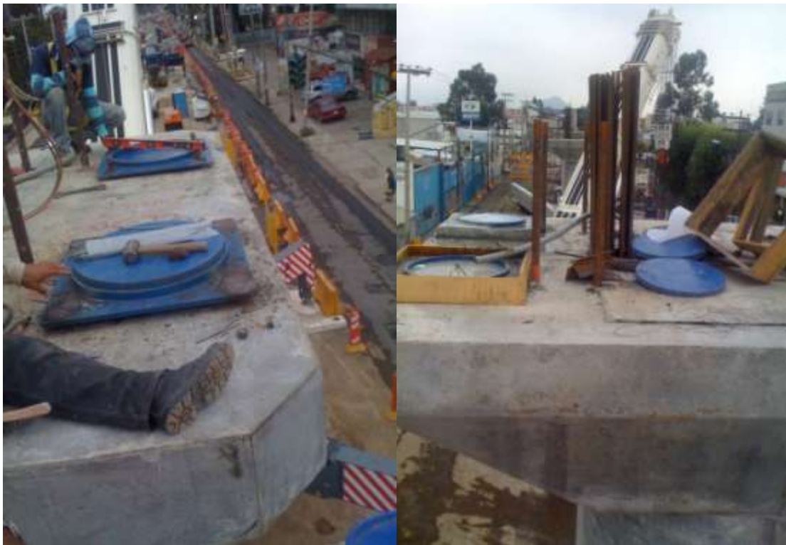
Figura 65. Colocación de encapsulados.
