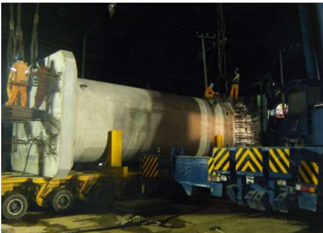
Figura 56. Llegada de columna prefabricada a sitio de montaje.
