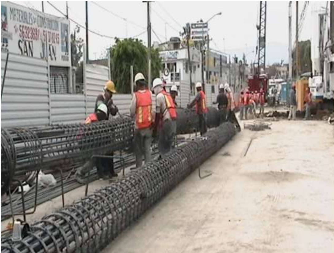
Figura 45. Armado de pilas.
