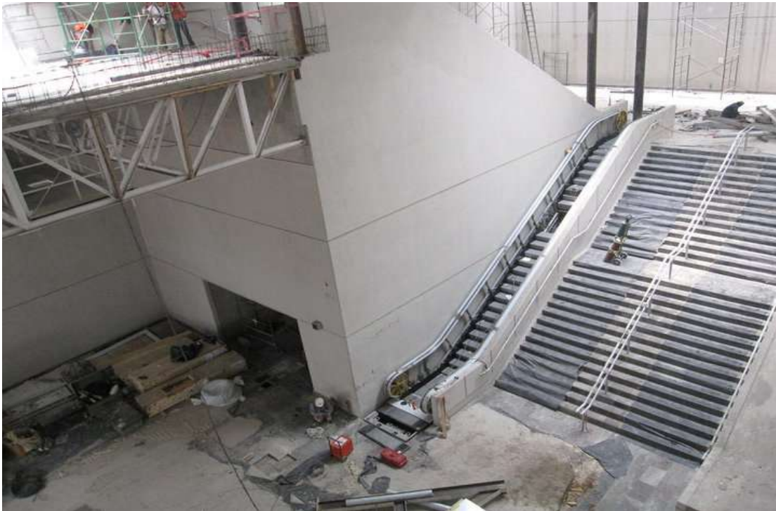
Figura 24. Vestíbulo de acceso a la estación.
