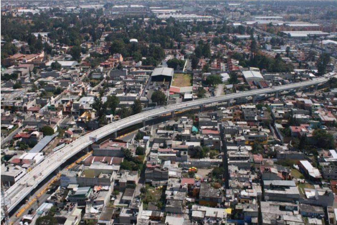
Figura 87. Vista aérea del viaducto elevado.
