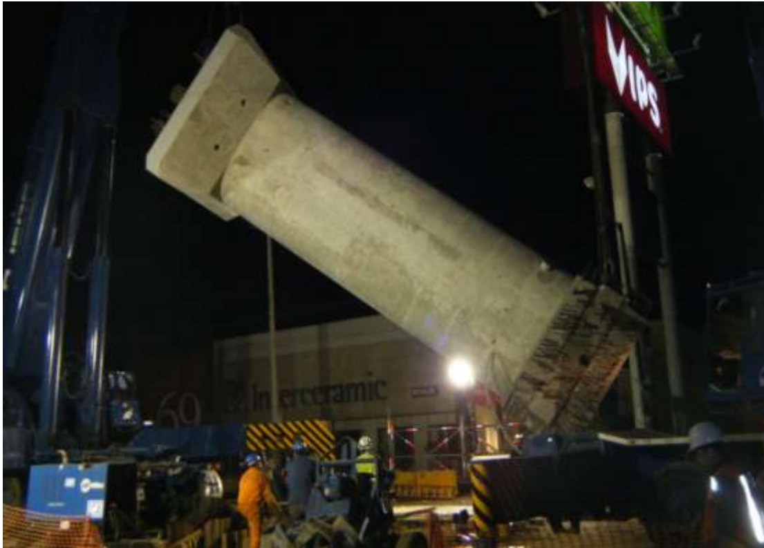
Figura 59. Columna alcanzando eje vertical.
