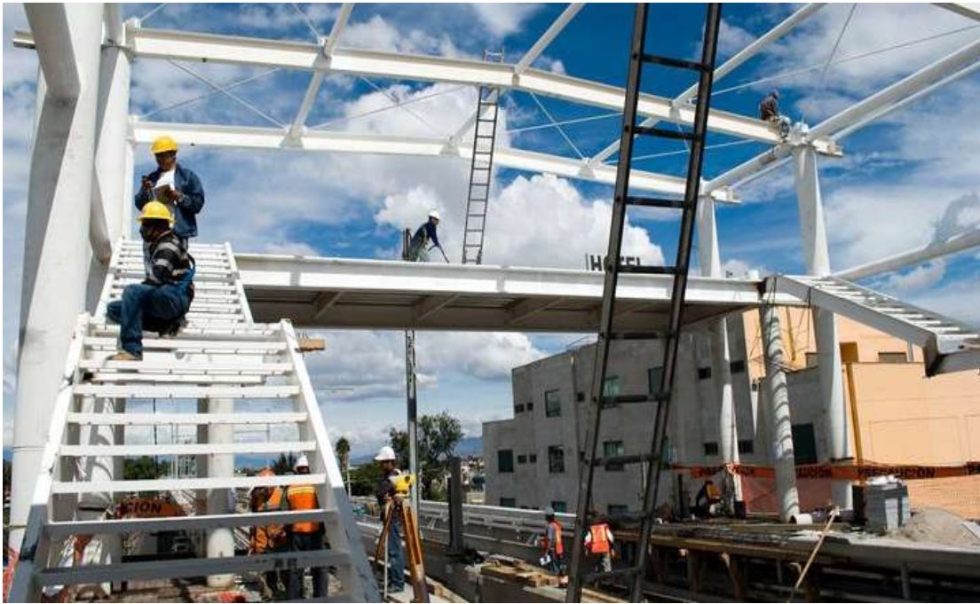
Figura 25. Pasarela de cambio de andén.
