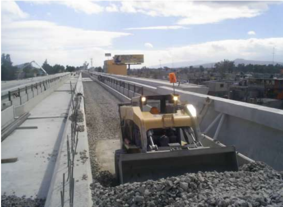
Figura 81. Repartición de balasto en losa de trabes.
