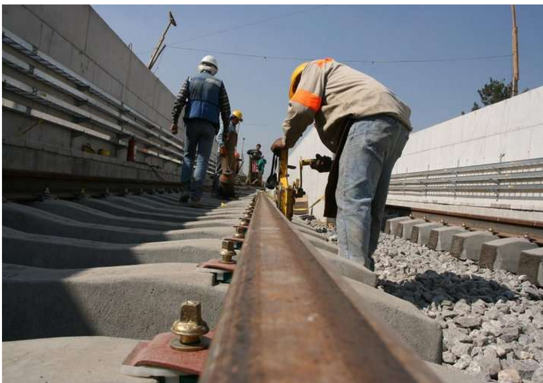
Figura 84. Instalación de rieles.
