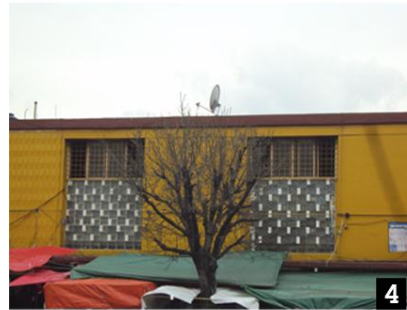
1-2. Fachada principal del mercado San Cosme, la disposición del estacionamiento es al frente vincula directamente con la calle principal. 3. La solución de la cubierta genera una iluminación y ventilación natural, la estructura es ligera y uniforme. 4. Detalle de la fachada. Se muestra un vano con rejillas de ventilación y cambio de aparejo en los ladrillos.
