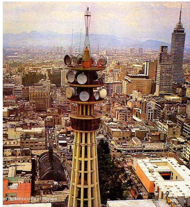
Vista de los años ochenta donde aparece en primer plano la conocida antena de Telmex, ubicada frente a la plaza del Buen Tono. (DDF).
