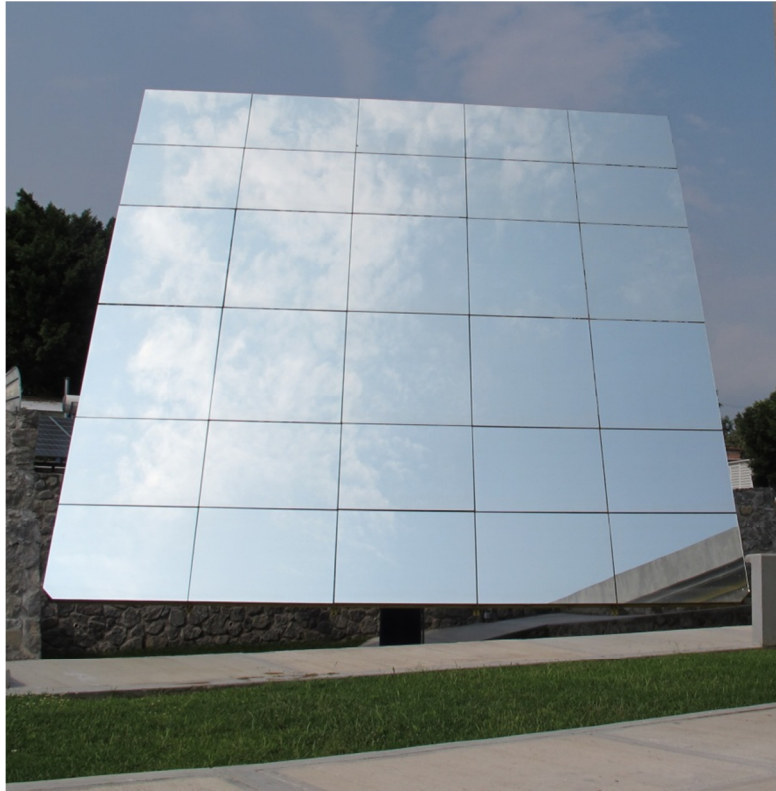
Fig. 1.10 Helióstato H81, utilizado para operar el HSAFR.
