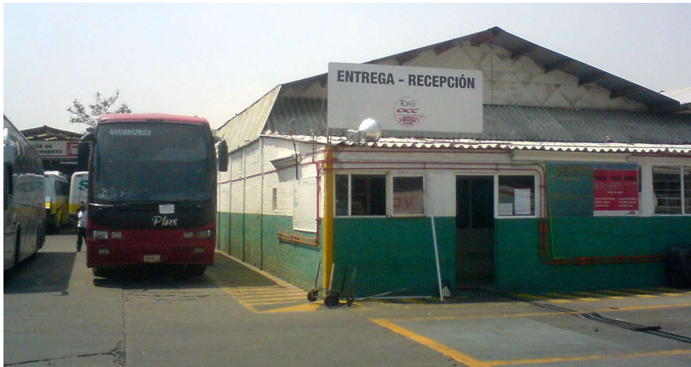
Figura 3.- Área de Entrega – Recepción de autobuses; en esta área se revisan las condiciones exteriores e interiores de los autobuses de varias Marcas.-
