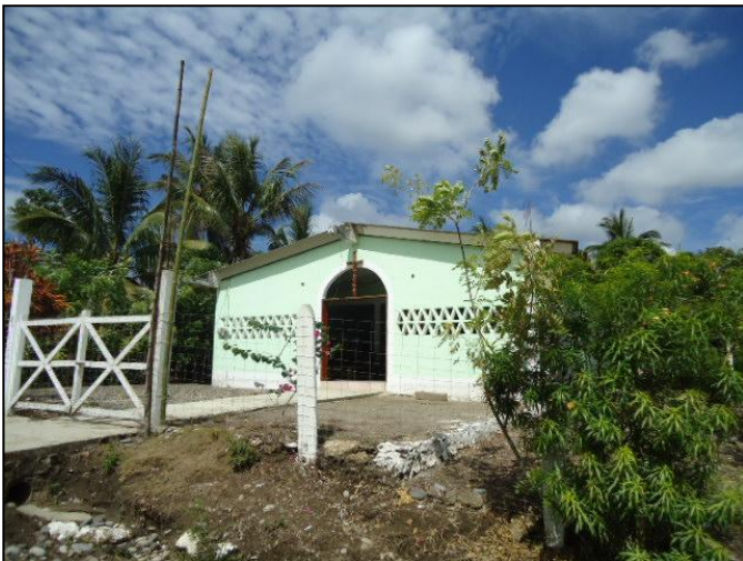
Fig 3. Iglesia de la Santa Cruz en La Encantada
