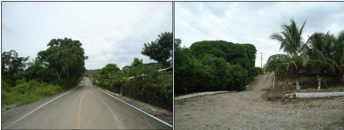
Fig 12. Camino asfaltado que actualmente está en construcción y camino de terracería que prevalece en el resto de la localidad
