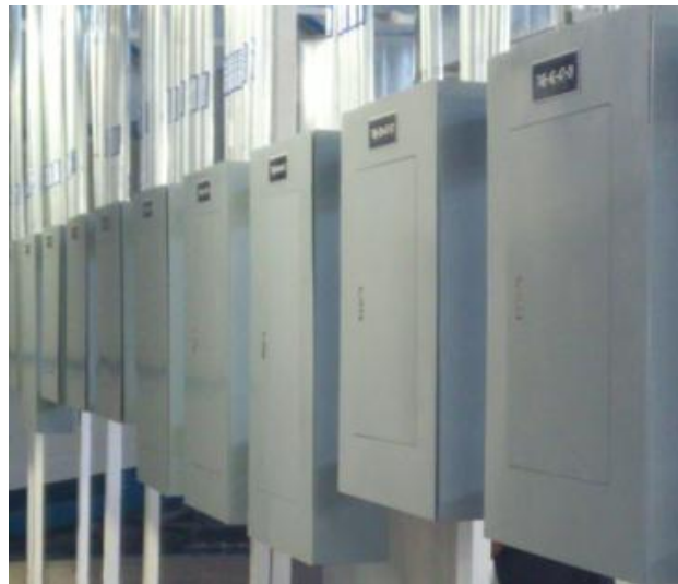
Fig. 2.5 Tablero para cargas mayores. Fuente: Tecnofarma Planta San Juan del Rio Qro.
