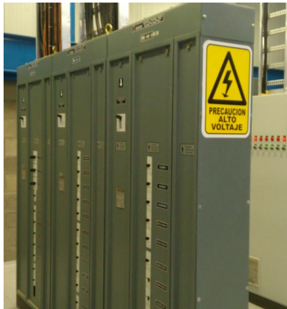
Fig. 2.2 Tablero general de energía eléctrica normal Fuente: Tecnofarma Planta San Juan del Río, Qro.
