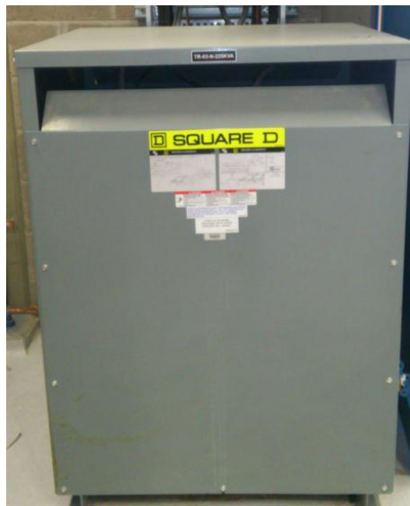
Fig. 1.4 Transformadores tipo seco de baja tensión Fuente: Tecnofarma Planta San Juan del Rio Qro.
