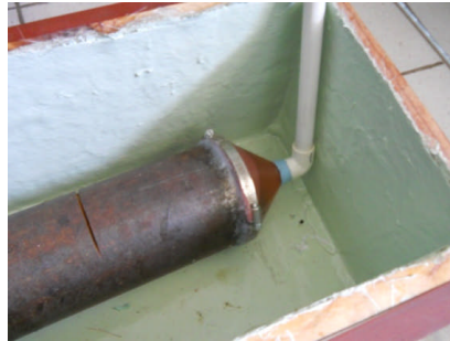
Fig. 2.7 Conexión de la salida del embudo al codo y tubo de PVC.
