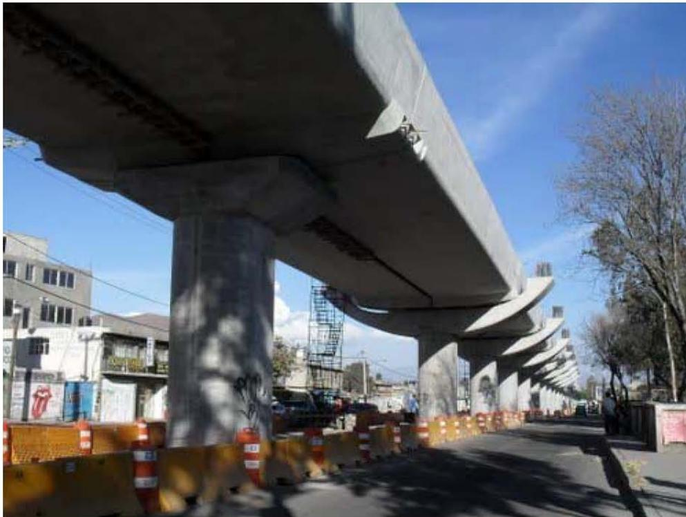
**Figura 1.4. Estructuras con elementos presforzados**
