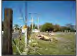
B. Infraestructura. Zona eléctrica zona rural, parte principal del predio.
