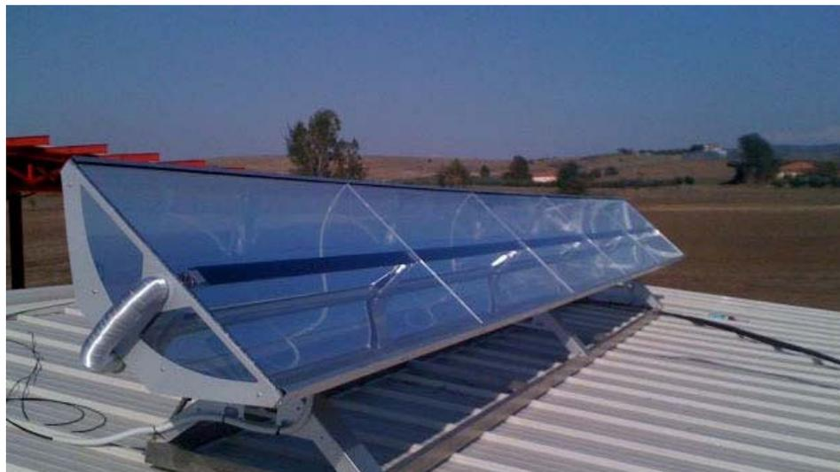
La versión del siguiente tipo de concentrador para su aplicación en baja temperatura y, por tanto, adecuada para el sector residencial, es el denominado concentrador parabólico compuesto (CPC).
