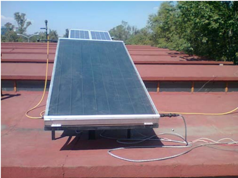
Figura 54: Colector solar encapsulado de placa plana con vista al sur
