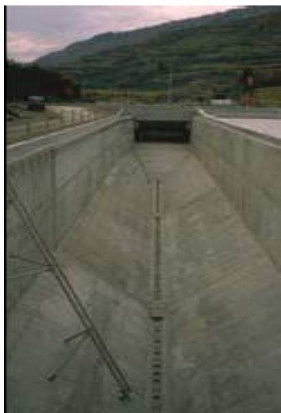
Foto imagen de un desarenador convencional de flujo horizontal.
