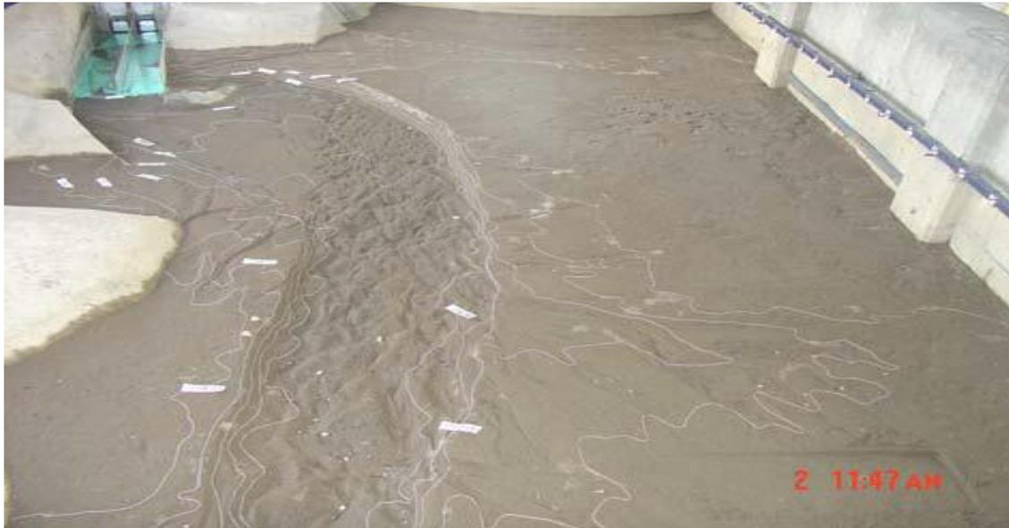
Figura 1.14 Fotografía Embalse colmado de azolve. Se aprecia el funcionamiento del desarenador.
