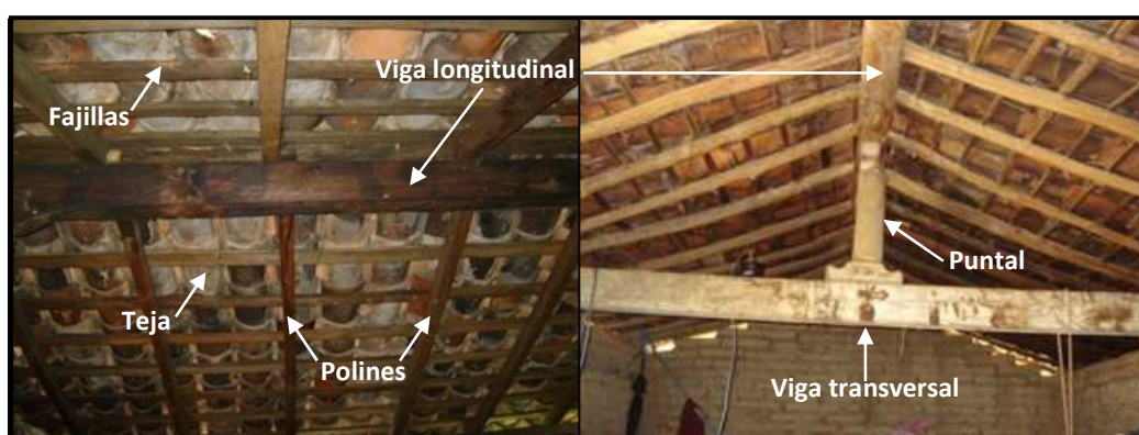
Figura 2.2 Sistema de techo en viviendas de adobe
