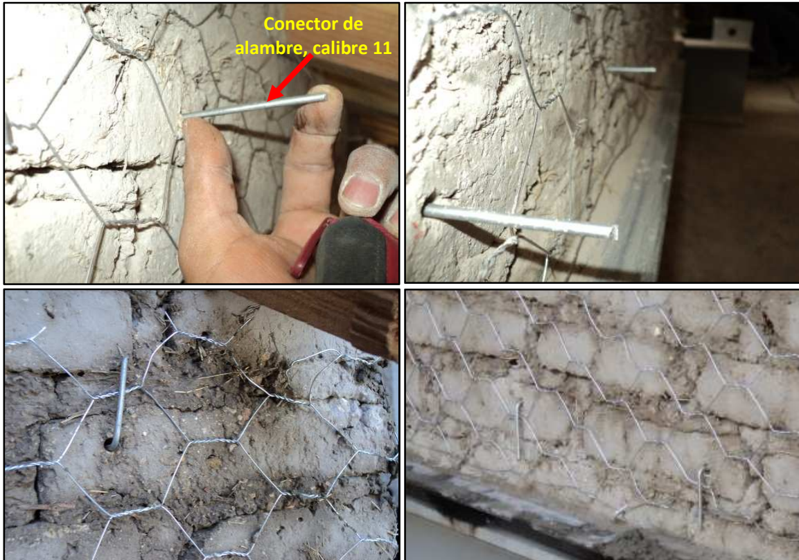
Figura 3.26 Colocación de conectores y anclaje a la malla hexagonal
