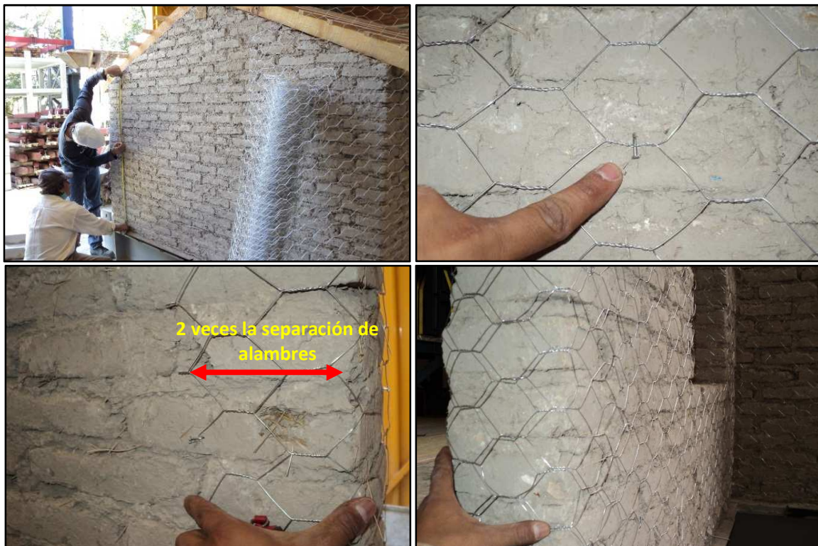
Figura 3.25 Colocación de malla hexagonal en muros y bordes
