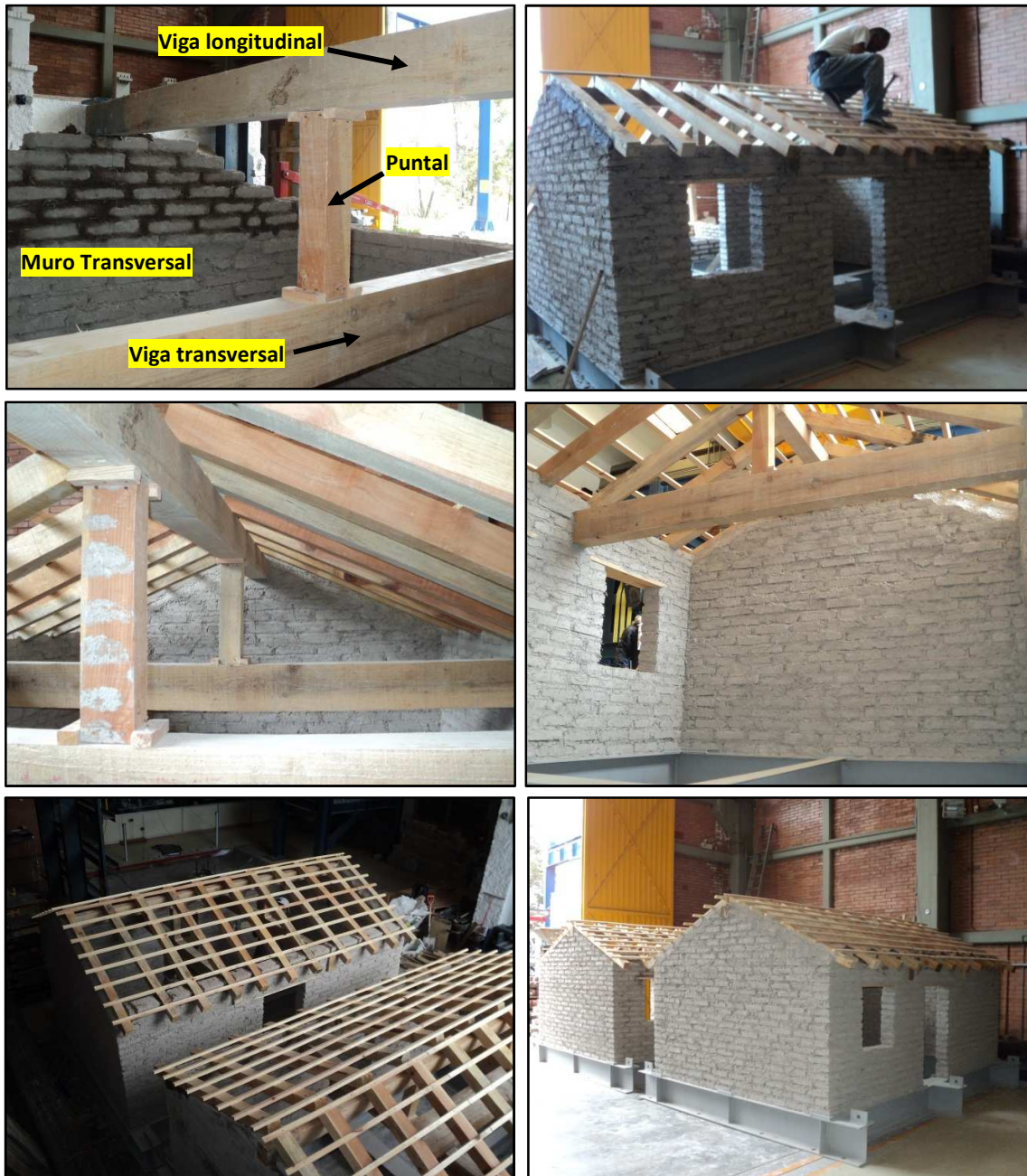
Figura 3.23 Construcción del techo y modelos terminados
