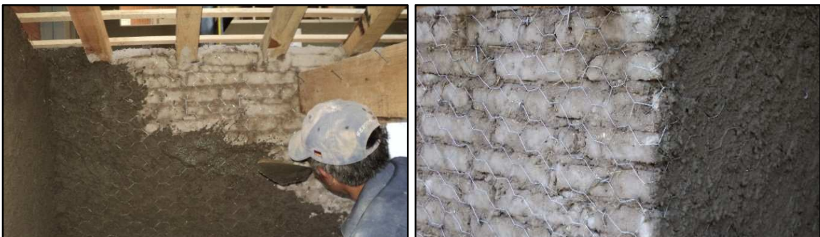
Figura 3.27 Zarpeada de mortero
