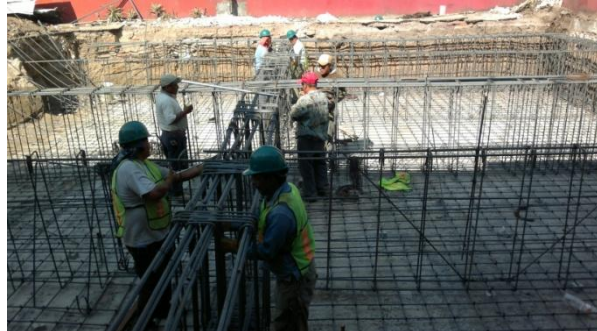
ARMADO DE TRABES PRINCIPALES
