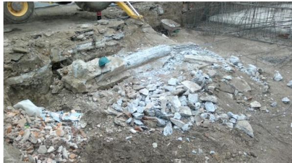
REMOCION DE MATERIAL DEL LUGAR
