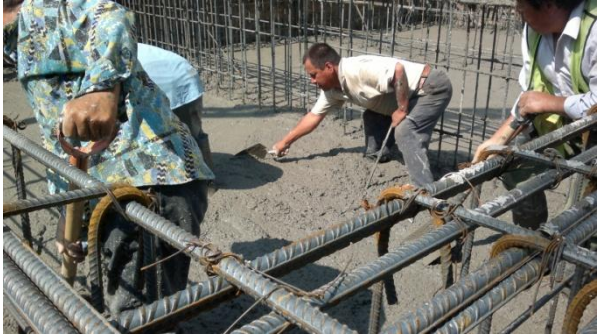
ESPARCIAMIENTO Y NIVELADO DE LA MEZCLA
