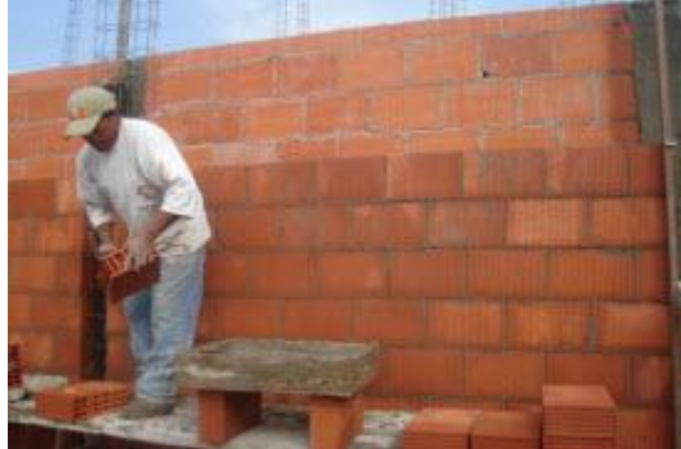
La aplicación en obra es igual al tabique rojo recocido, block de cemento arena, tabicón, etc.
