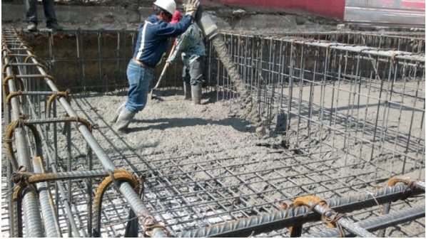
VACIADO DE CONCRETO
