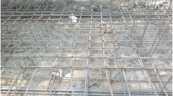
ARMADO DE LOSA FONDO CON DOS CAPAS DE VARILLAS DE 3/8 DE 20 X20, LA PRIMERA SEPARA POR LOS LLAMADOS "POLLOS" Y LA SEGUNDA POR SILLETAS
