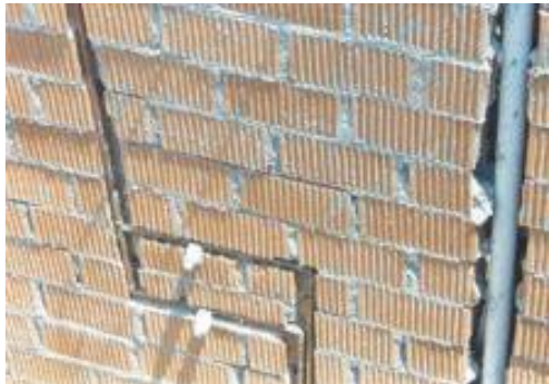
Facilidad en el ranurado para instalaciones eléctricas e hidráulicas.
