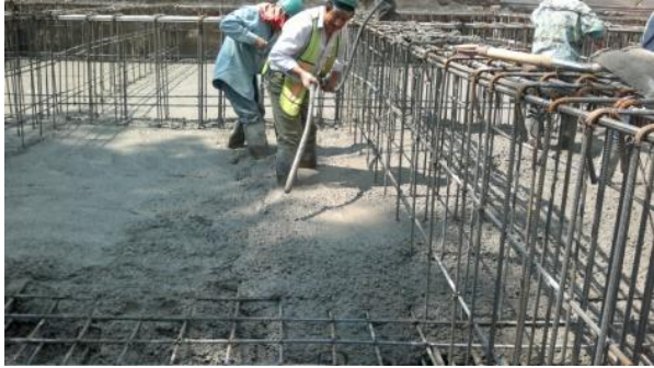
VIBRADO DE CONCRETO
