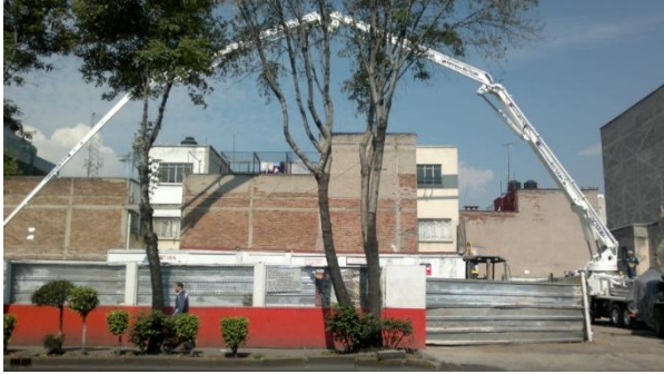
BOMBEADO DE CONCRETO
