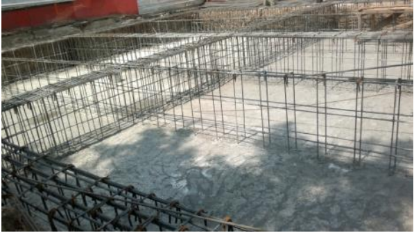
ARMADURA LISTA PARA COLOCACION DE CIMBRA
