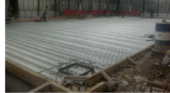
COLOCACION DE LOSA TAPA CON LOSACERO
