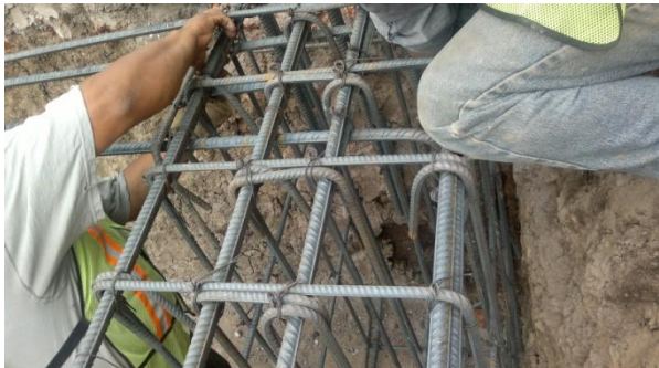
DETALLE DE TRASLAPE DE VARILLAS EN ESQUINA
