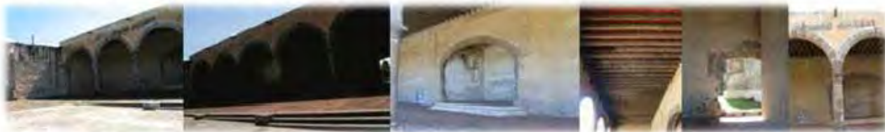
CAPILLA ABIERTA DEL EXCONVENTO SAN FRANCISCO TEPEYANCO
