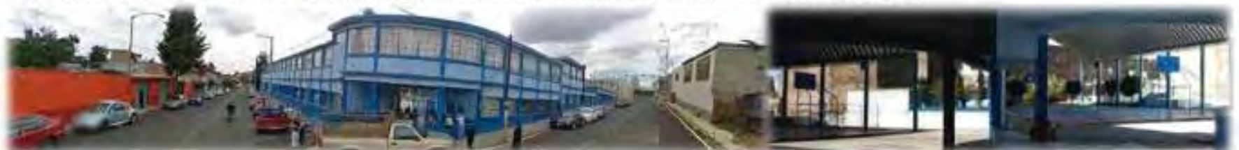
VISTAS DE CALLE BENITO JUÁREZ , CUAUHEMOC Y DE LA ESCUELA PRIMARIA , COLINDANCIA UBICADA AL NORESTE DEL CONVENTO.
