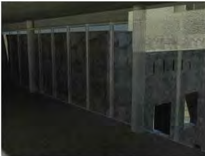
EDIFICIO PRINCIPAL – TERCER NIVEL
