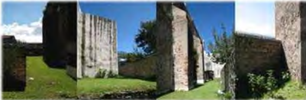
2.- CONTRAFUERTES EN EL EXTREMO NORTE DEL EXCONVENTO
