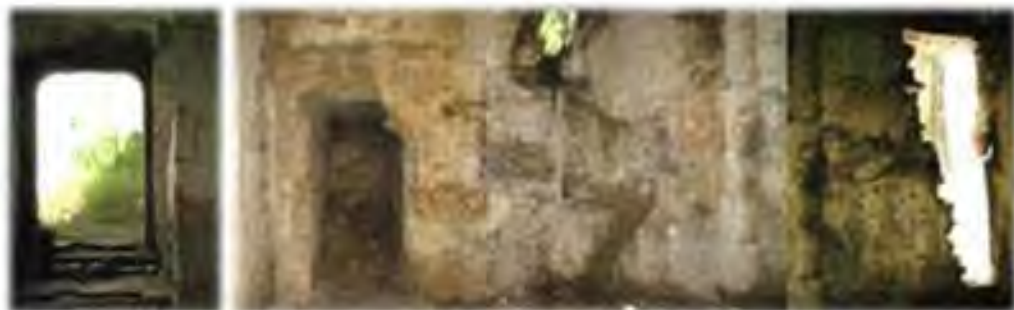
9.- IMAGÉNES DE ACCESO A ESCALERA Y A SACRISTIA DEL EXCONVENTO.
