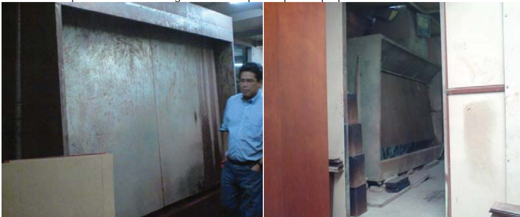
Foto23. Dos tipos de cortinas de agua utilizadas por empresas pequeñas.
