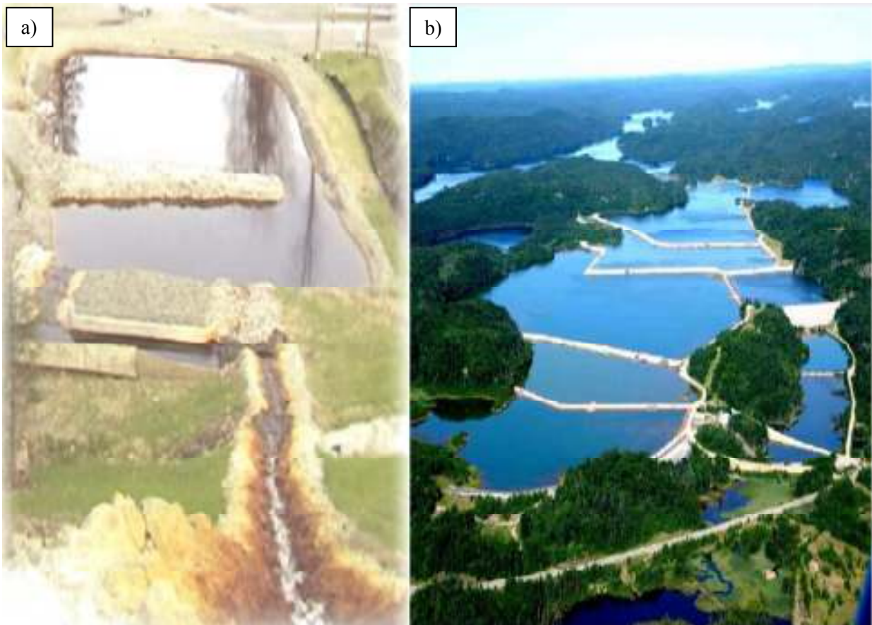
Figura 31: a) humedal aeróbico artificial (Skousen et al., 1998); b) conjunto de humedales aeróbicos artificiales escalonados (Sánchez-Rial y Ferreira-Centeno, 2011).
