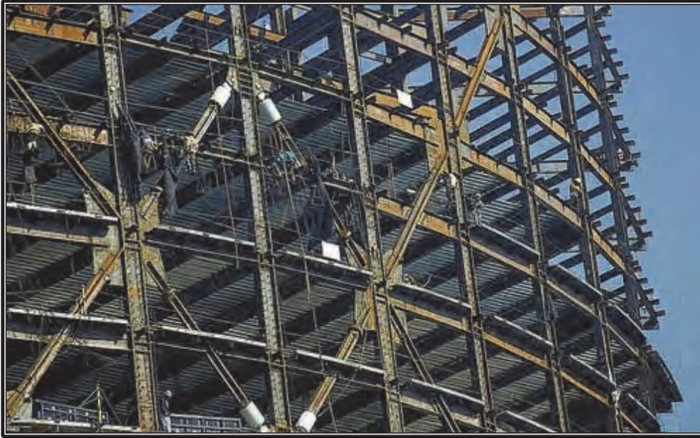
Figura 2.85: Amortiguadores sísmicos de la Torre Mayor, México, DF.
