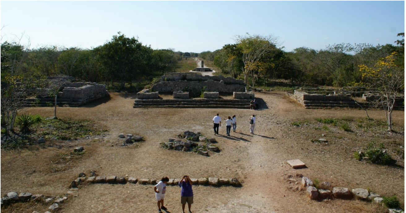
Figura 54.- Estructuras 5, 7 y 9 vistas desde la estructura 1. Dzibilchaltún, Yucatán.
