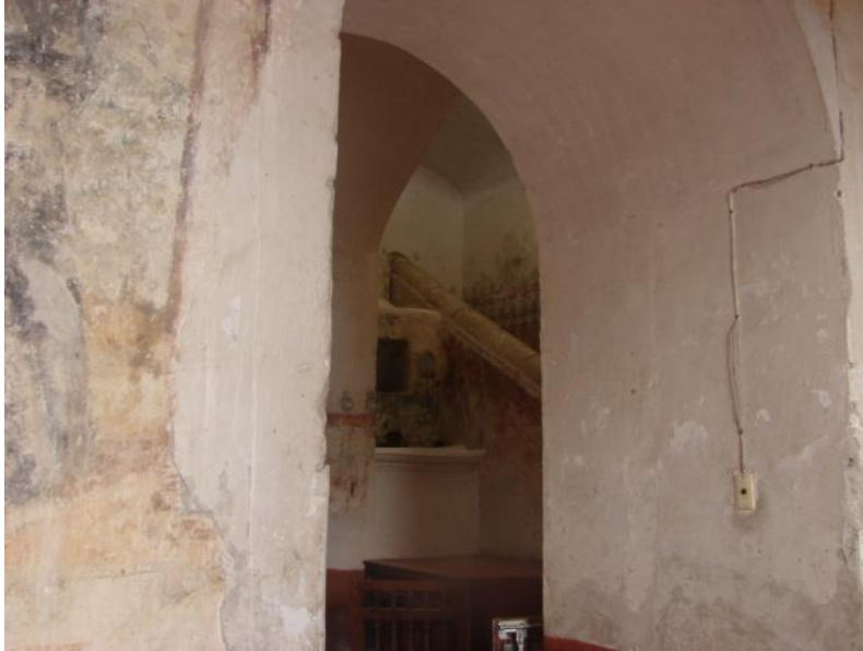
Entrada actual al cubo de la escalera
