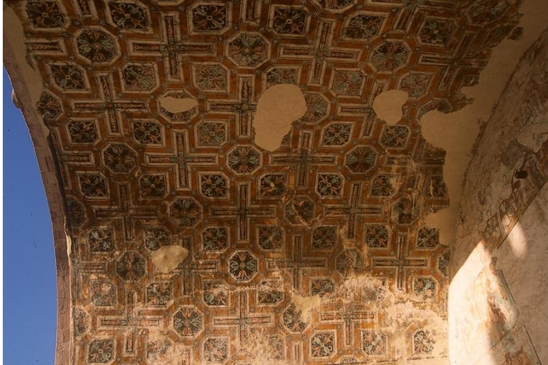
Cubierta de artesones en la capilla abierta de Actopan
