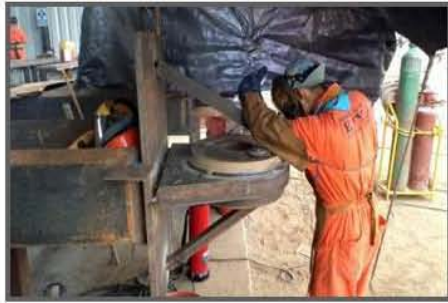
Aplicación de soldadura a orejas del marco de anastre
