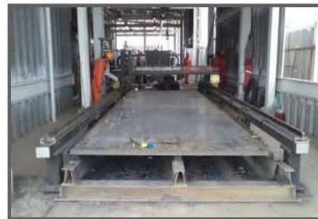
Habilitado de placa para patines de vigas
