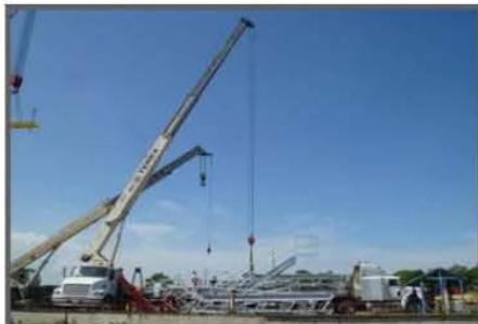
Llegan a sitio escaleras
