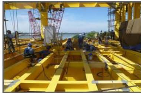
Montaje y soldadura de sistema de piso en cubierta inferior y superior
