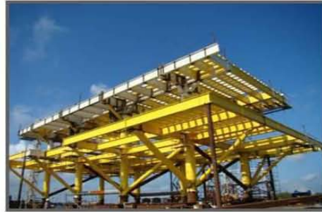
Izaje de volados en cubierta inferior
