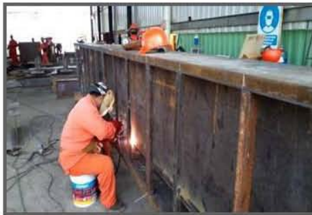
Aplicación de soldadura a vigas de la cubierta inferior
