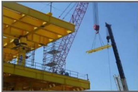
Montaje y soldadura de sistema de piso en cubierta inferior y superior
