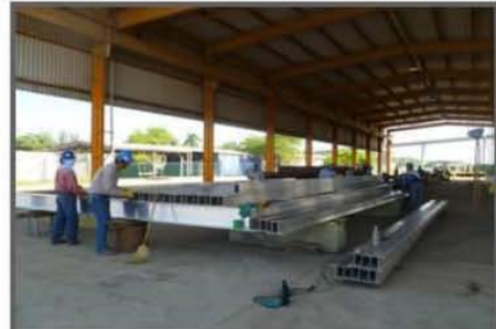
Armado de helipuerto
