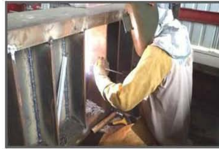
Aplicación de soldadura a cantabones en vigas del marco de anastre.
