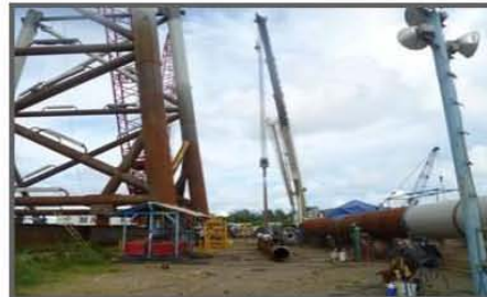
Montaje de anisbramientos del Jacket
