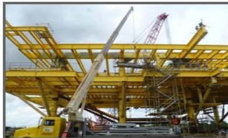
Montaje de rejilla de la cubierta inferior
