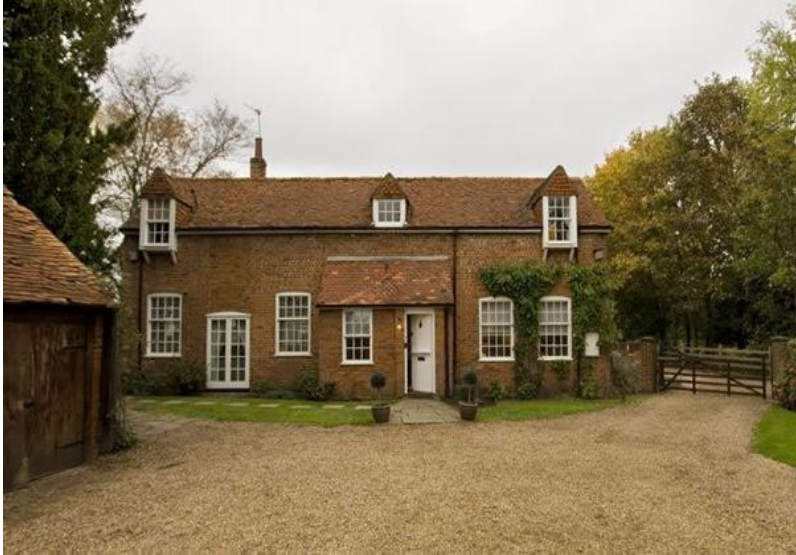
Vista de la Casa Anexa (Habitaciones)
