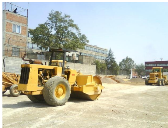
Figura 5.2. Compactación de la plataforma.
