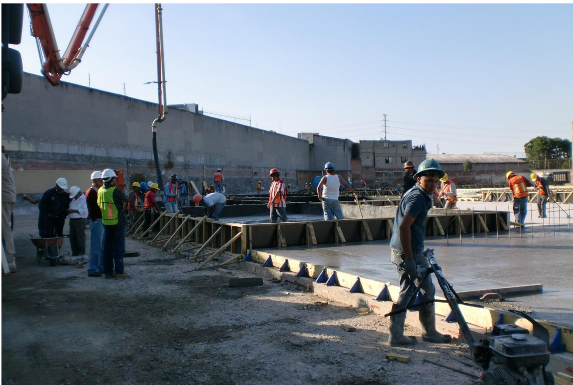
Figura 5.21. Colado de paneles de concreto.
