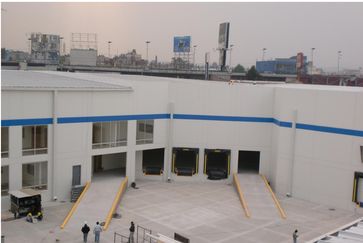
Figura 3.24. Rampas de concreto, que comunican el patio con la plataforma directamente.
