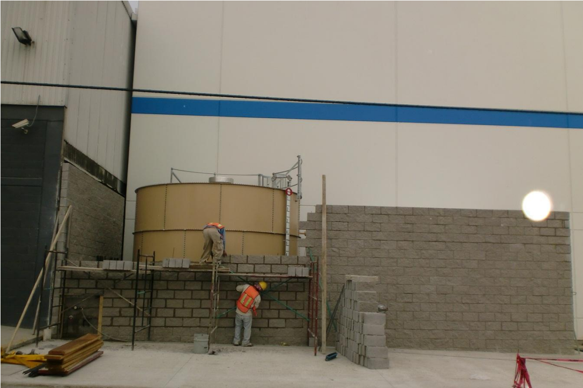
Figura 3.20. Tanque de agua.
