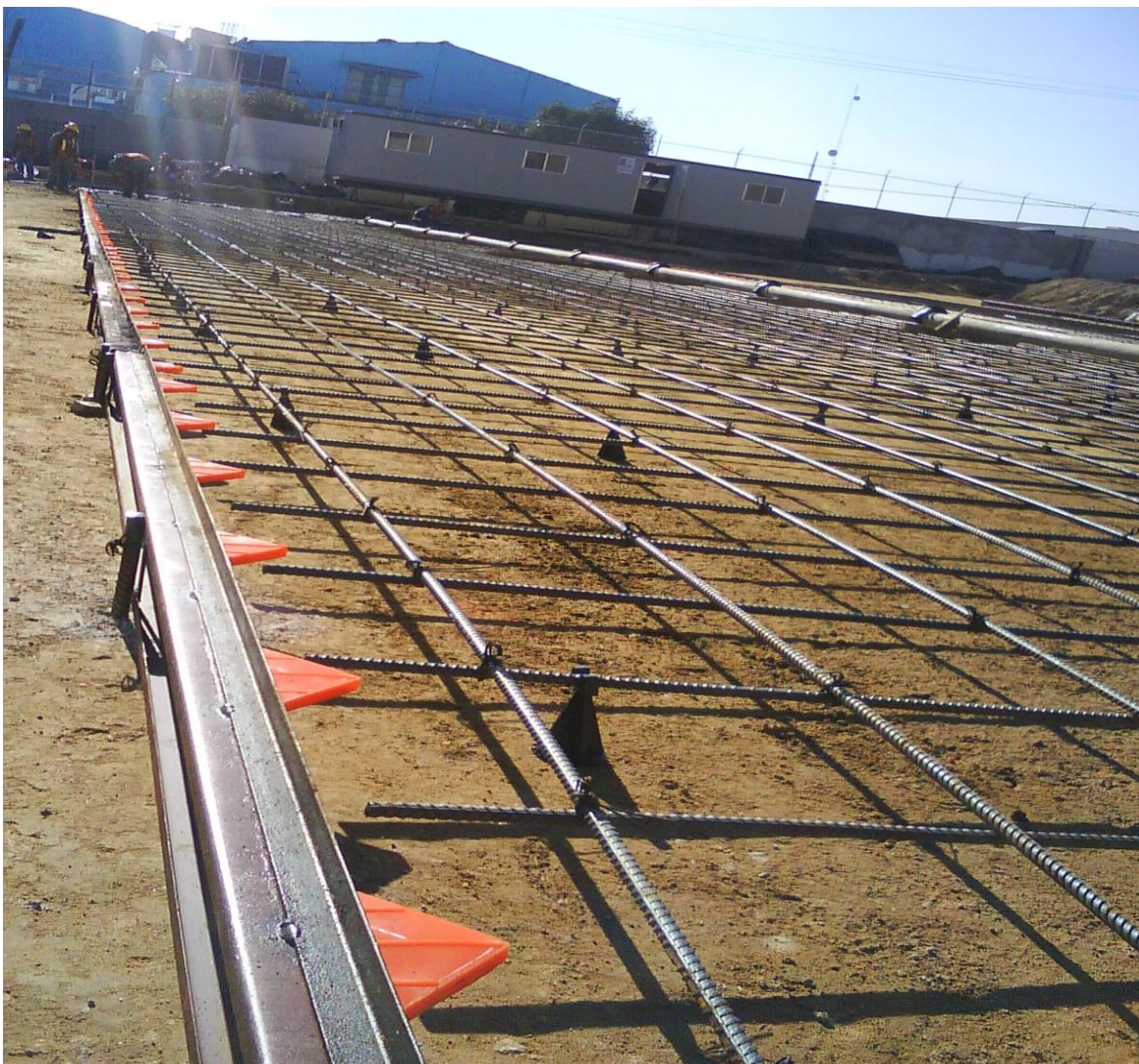
Figura 5.5. Armado de firme listo para ser colado.
