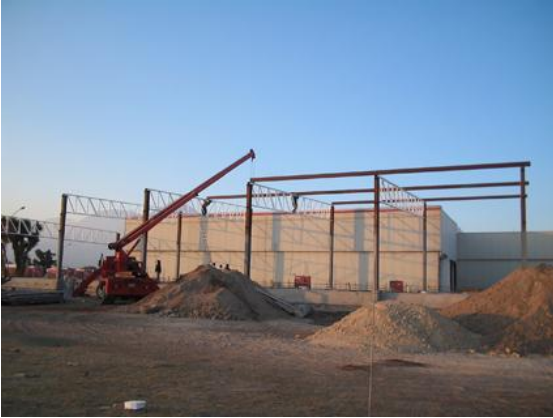
Figura 4.3. Nave industrial en construcción.
