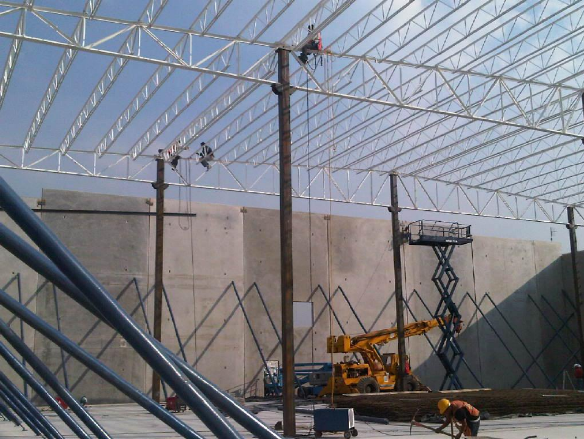
Figura 3.15. Colocación de joist.
