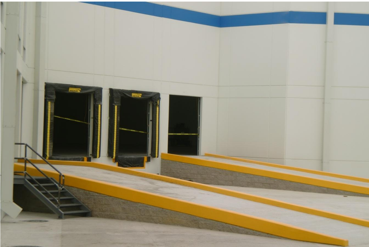
Figura 3.5. Rampas de concreto.
