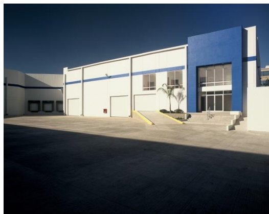
Figura 4.10. Nave de muros prefabricados.
