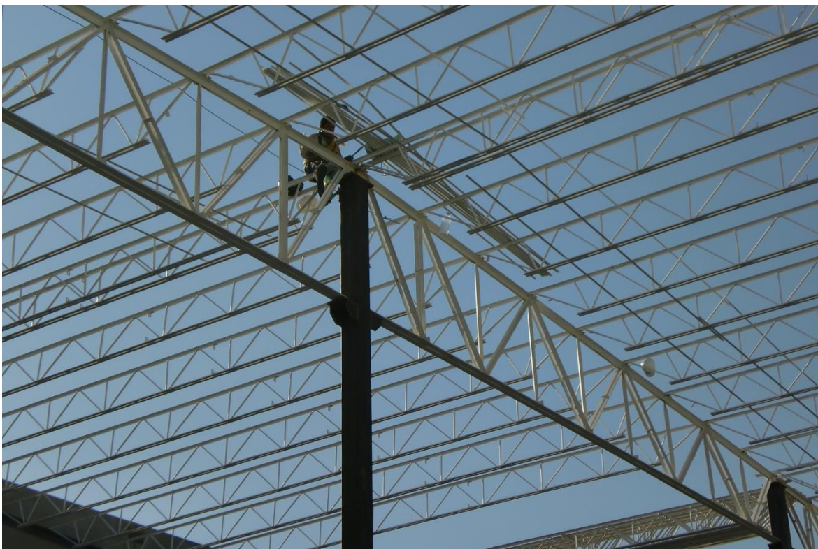
Figura 3.14. Montaje de armadura principal.
