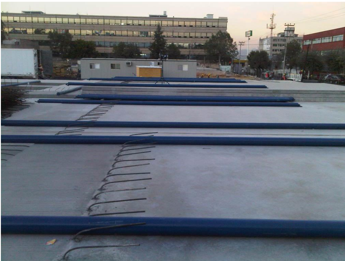
Figura 5.23. Bracers fijados a los paneles.
