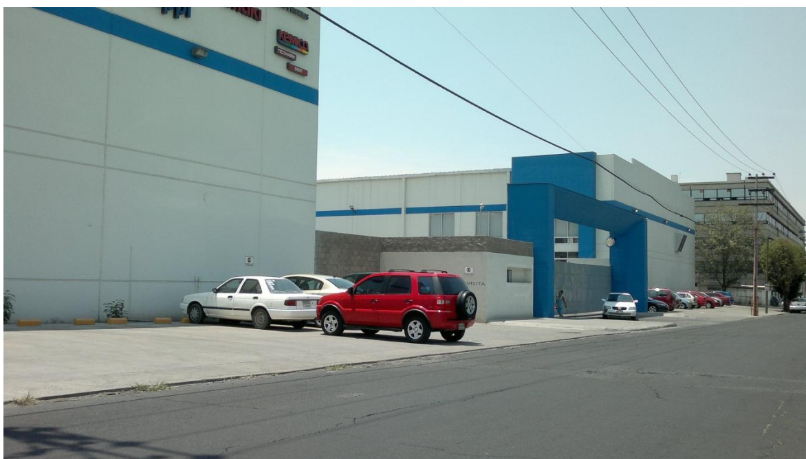
Figura 3.6. Estacionamiento a un costado de la fachada.
