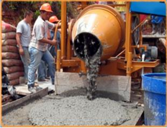
Figura 4.13. Realizado de concreto en obra.
