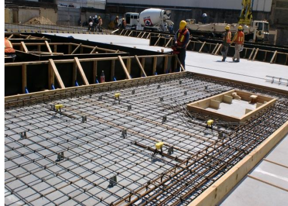
Figura 4.8. Elaboración de muros prefabricados.
