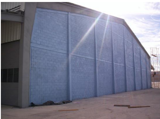
Figura 4.9. Nave de block.
