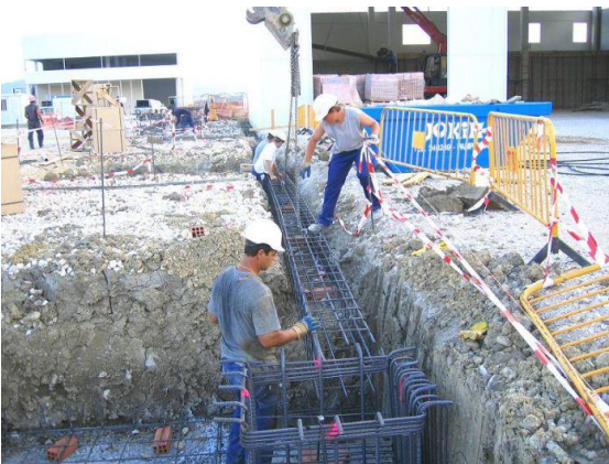
Figura 4.5. Cimentación robusta para nave convencional.
