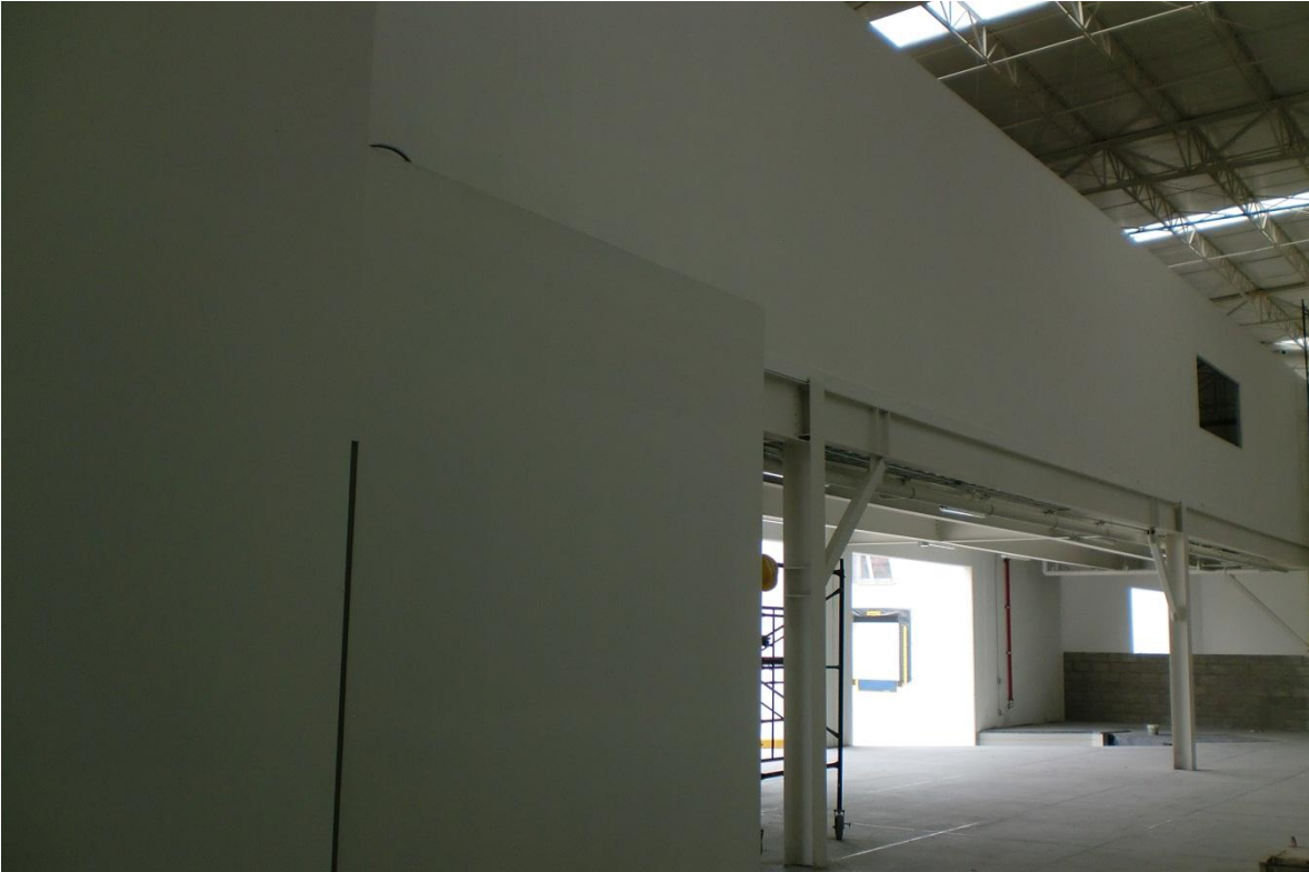
Figura 3.13. Estructura de mezzanine.
