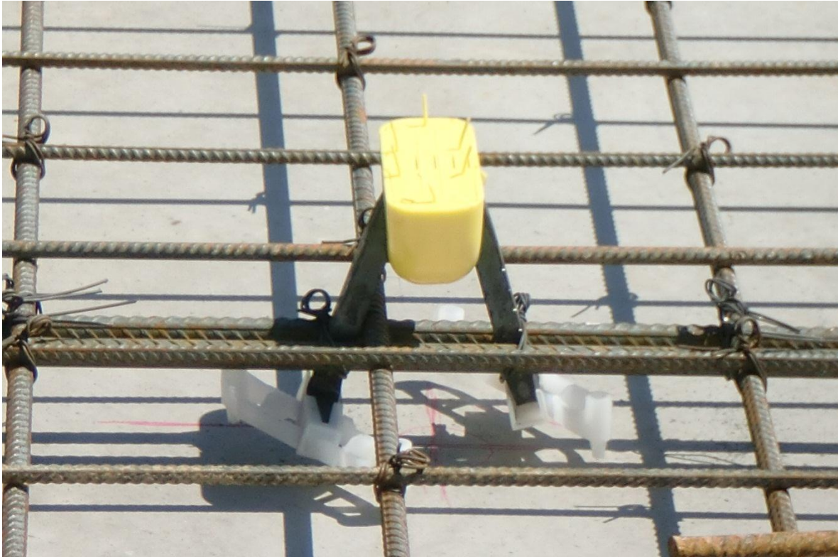
Figura 5.15. Colocación de lifting insert.
