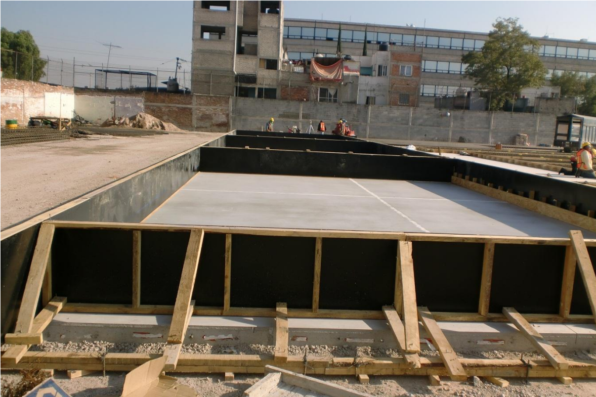
Figura 5.11. Cimbra para apilar muros.
