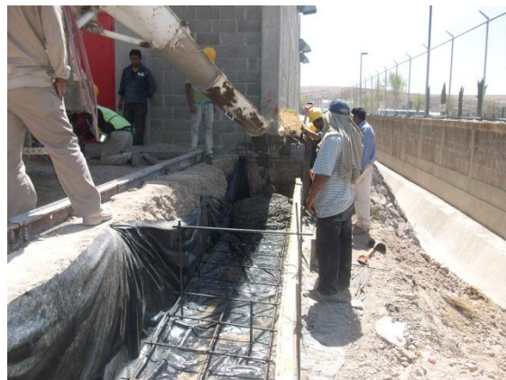
Figura 4.6. Cimentación de muros prefabricados.
