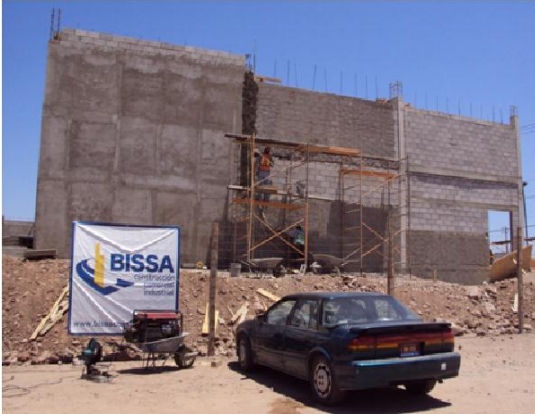
Figura 4.7. Fabricación de muros convencionales.
