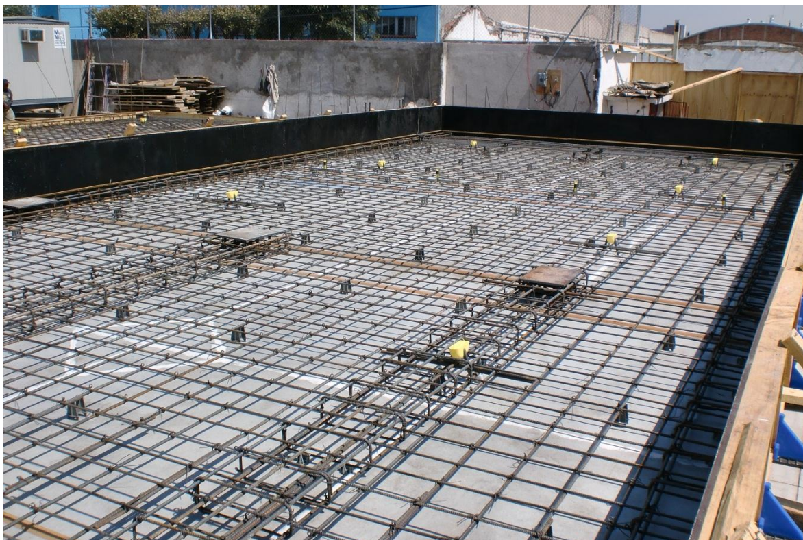
Figura 5.17. Armado final de un panel.
