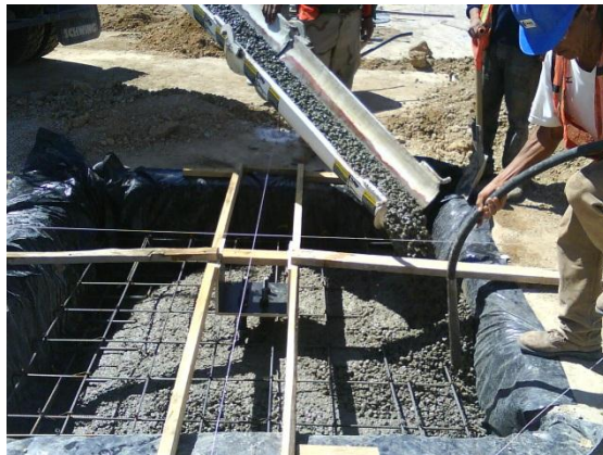
Figura 3.11. Colado de zapata aislada.
