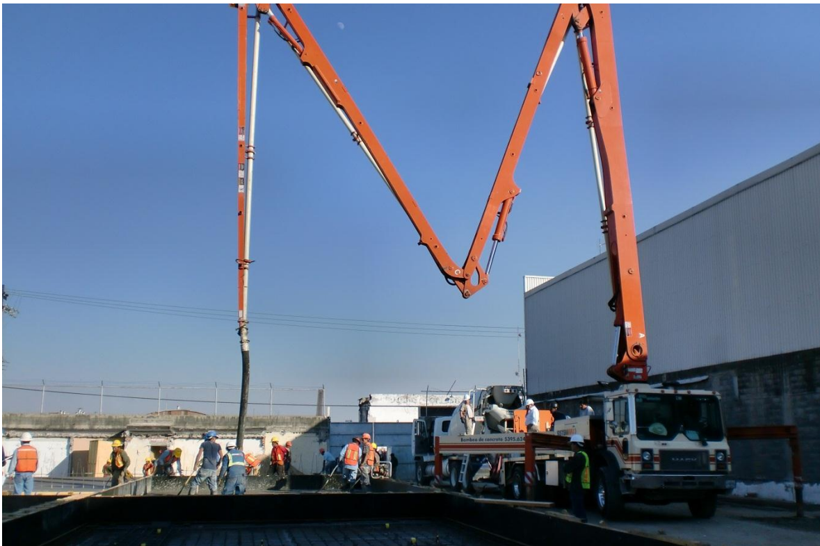
Figura 5.19. Bomba tipo pluma en operación.
