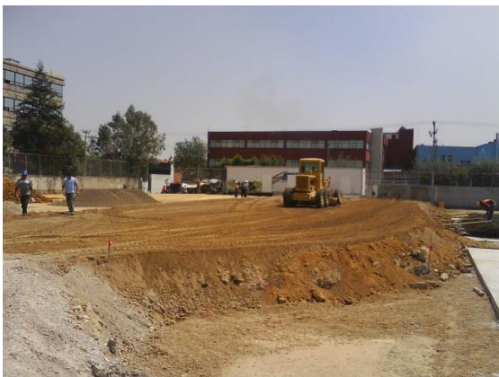
Figura 5.1. Formación de la plataforma.
