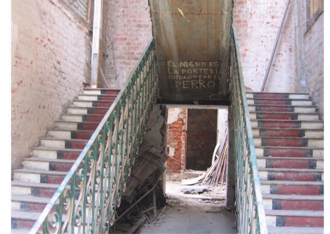
Escalera de acero y barandales de hierro forjado.
