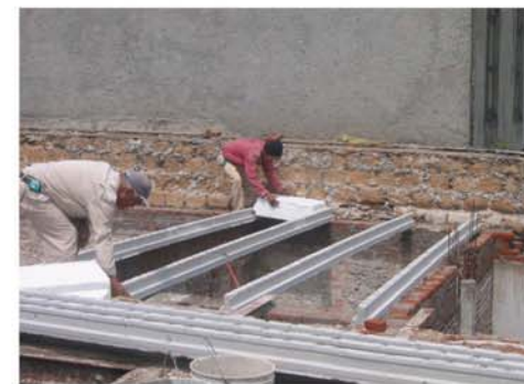
vigueta y bovedilla, Mina #143
