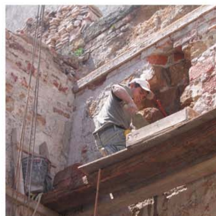
Sustitución de material, Mina #143
