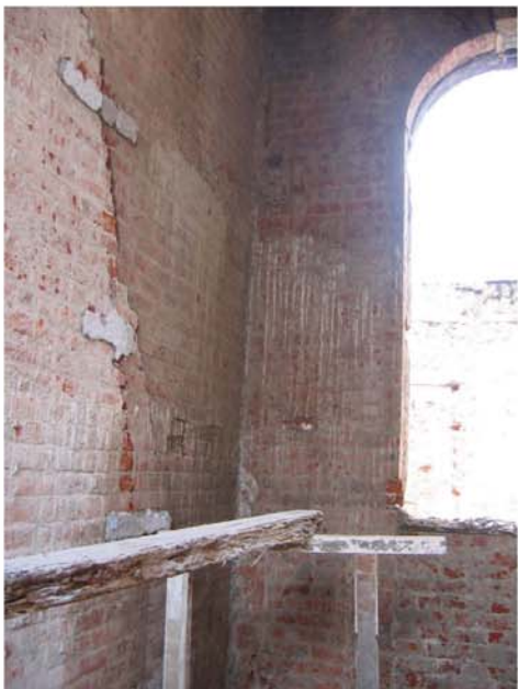
reparación de grieta en escalera, Mina #143
