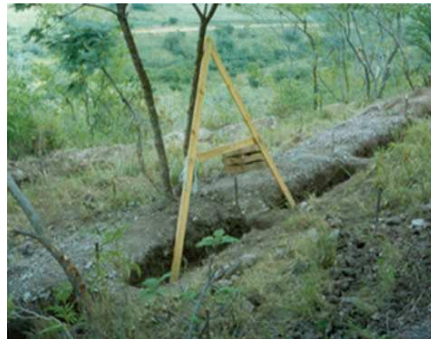
Fig 33. Zanja tipo trinchera
