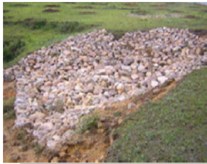
Fig 35. Ejemplo de cabeceo de cárcavas.
